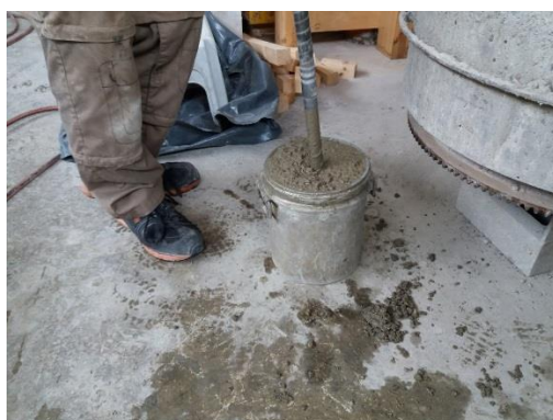
Slika 61: Zgoščevanje z vibracijsko iglo
