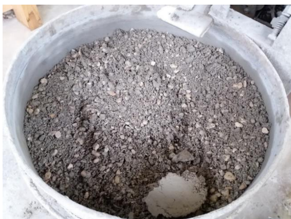
Slika 50: Beton neustrezen za vgradnjo
