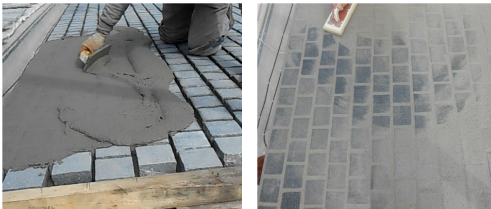
Slika 42: Polaganje in fugiranje granitnih kock z elastično-cementno maso.
