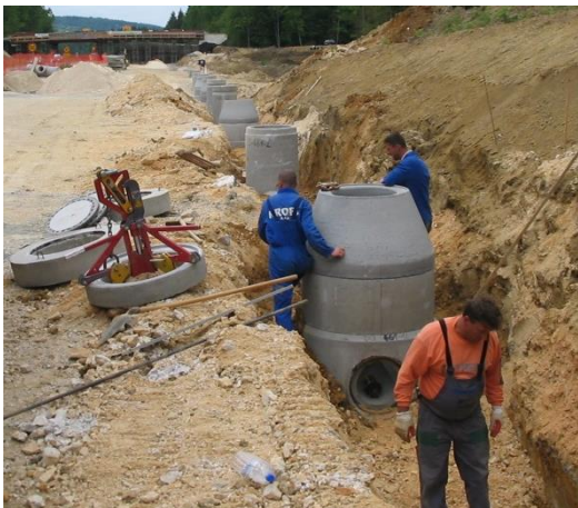
Slika 49: Vgrajen betonski tipski jašek.
