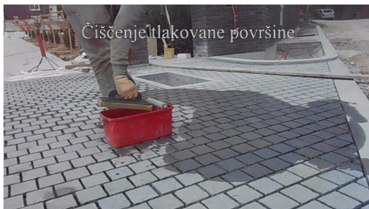
Slika 64: Video prikaz vgrajevanja gradbenih elementov – primer.
