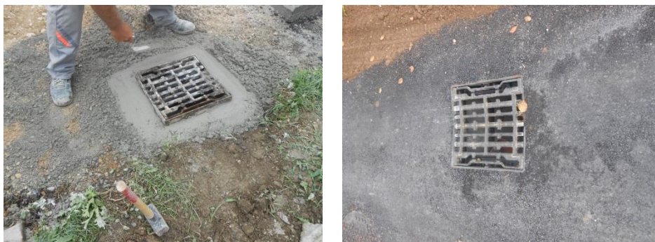
Slika 56: Vgradnja LTŽ rešetke na betonski jašek.
