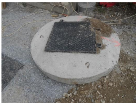
Slika 55: Obbetoniran LTŽ-pokrov.
