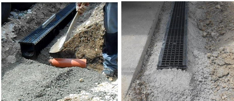
Slika 58: Vgradnja linijske kanalete.
