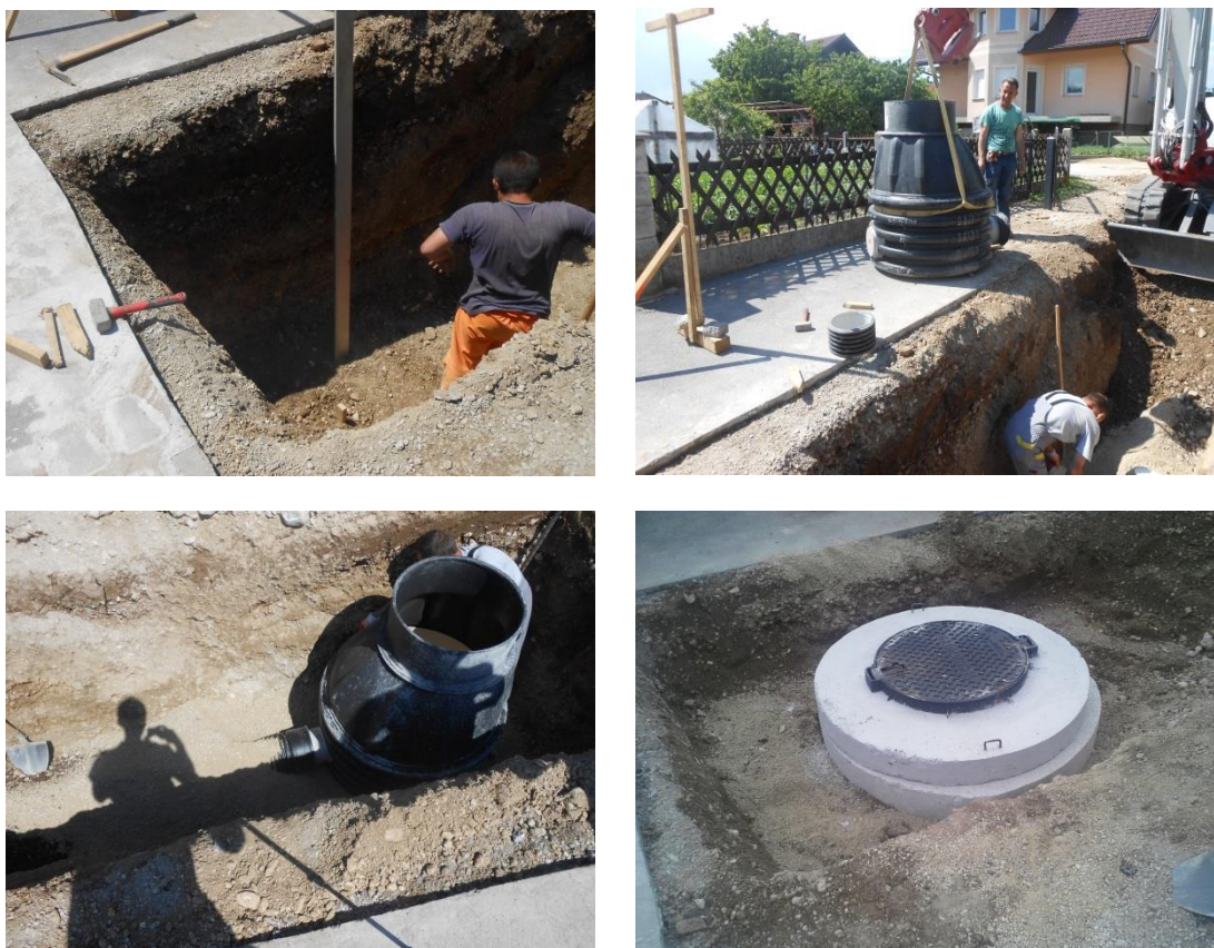
Slika 53: Vgradnja jaška iz umetne mase z obbetoniranim LTŽ-pokrovom.
