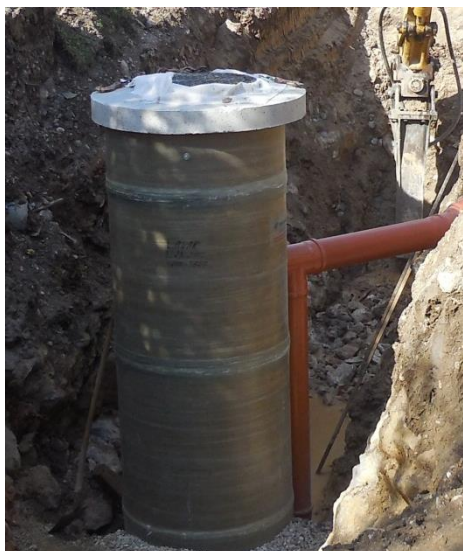
Slika 29: Jašek iz poliestra z obbetoniranim pokrovom.
