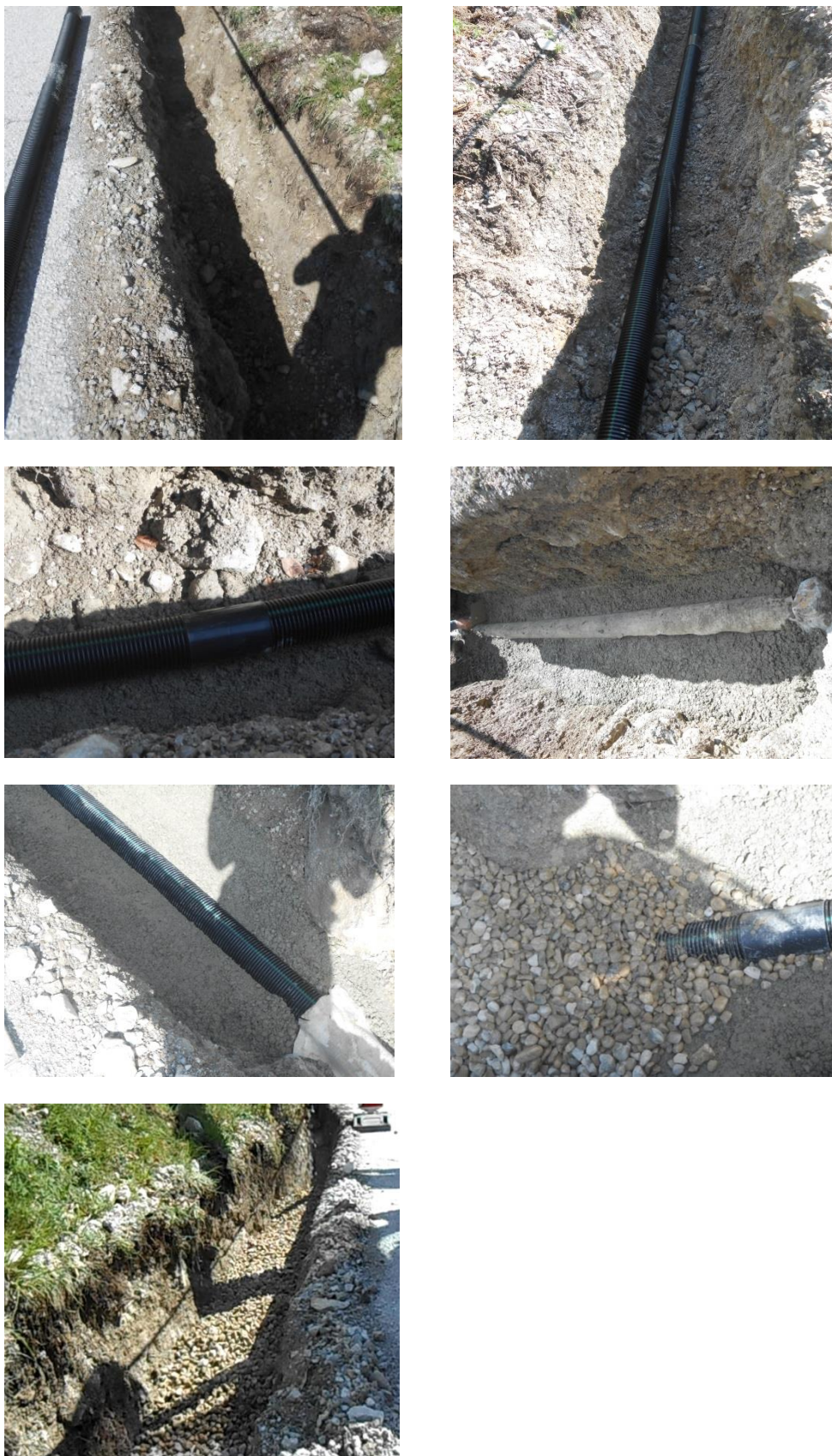
Slika 47: Polaganje PE-HD gibljivih cevi na betonsko posteljico.
