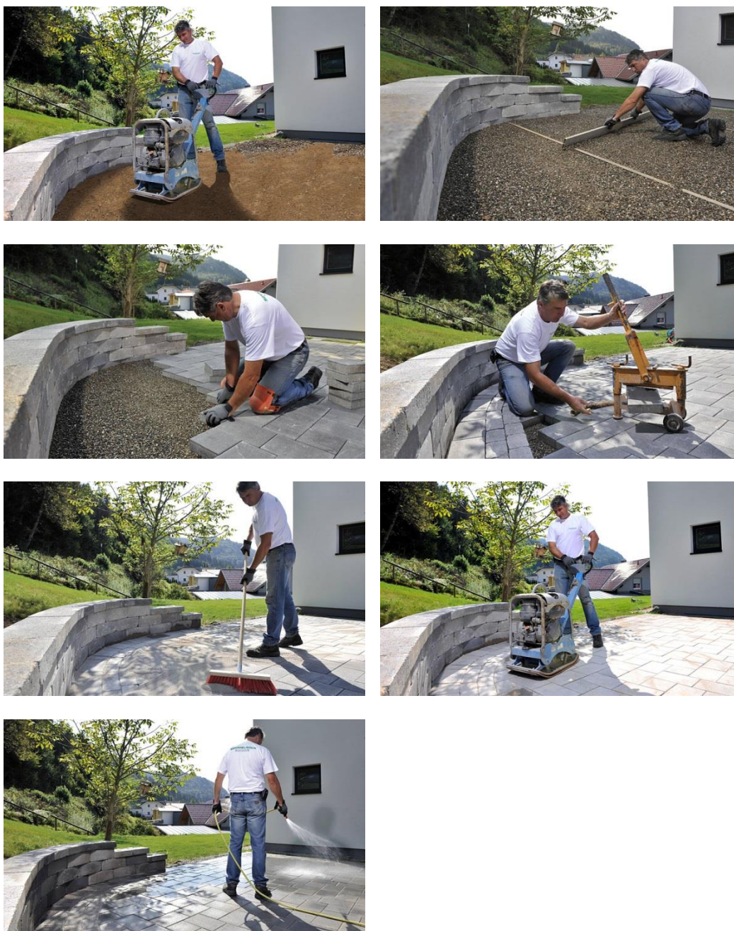
Slika 43: Pravilno polaganje tlakovcev (SEMMELOCK).
