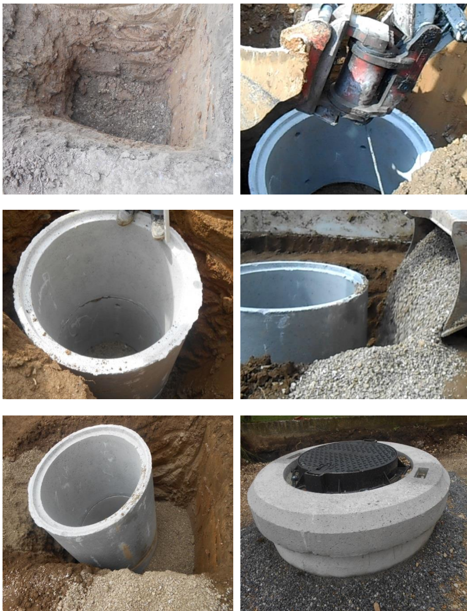
Slika 61: Izdelava ponikovalnice iz perforiranih betonskih cevi krožnega prereza.
