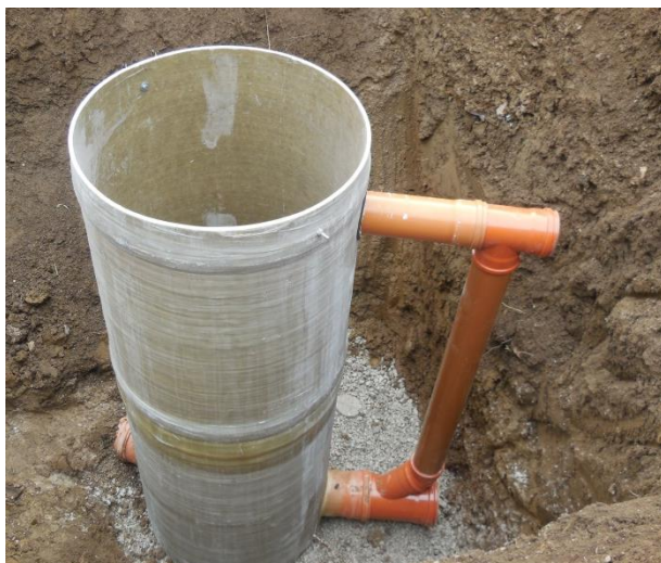
Slika 27: Kaskadni jašek iz poliestra.
