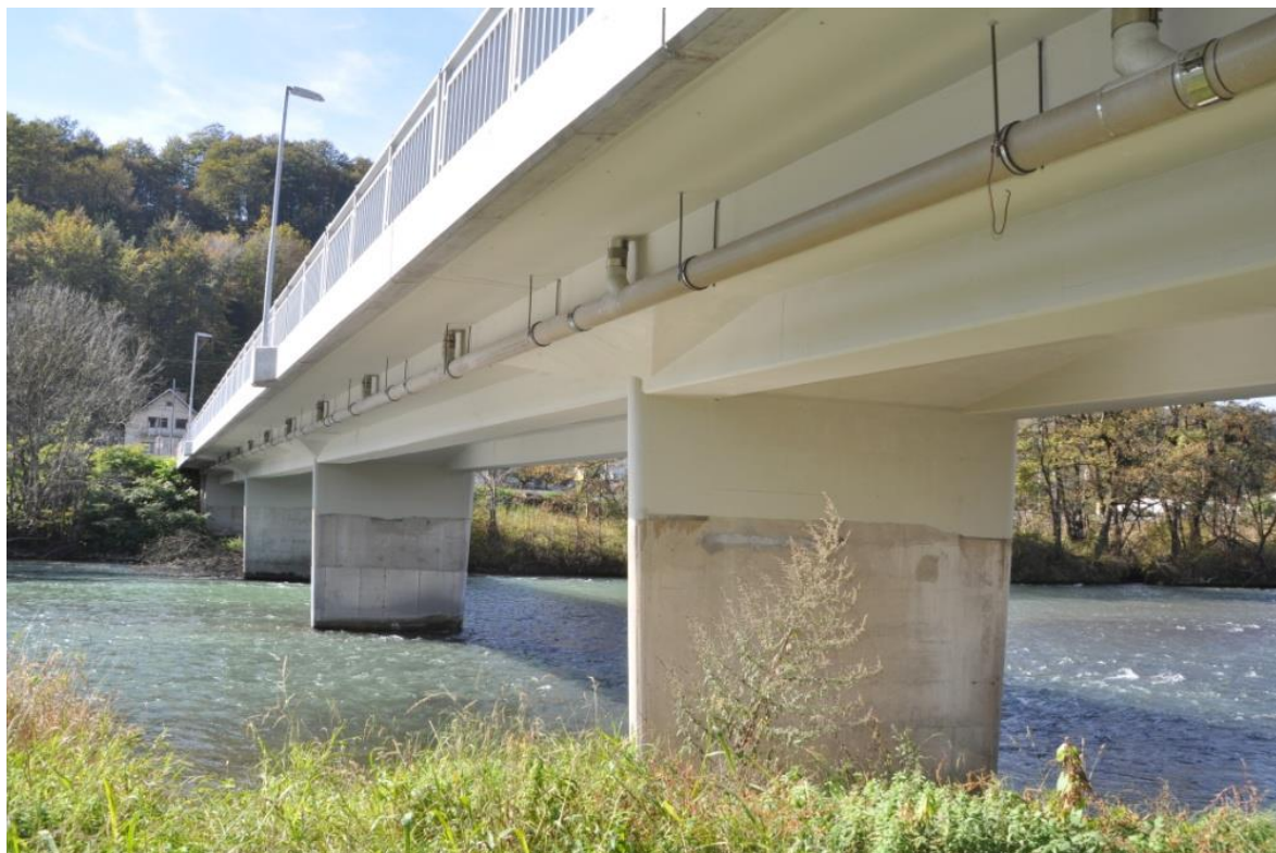
Slika 25: Zaščita betona 2 (lasten vir)
