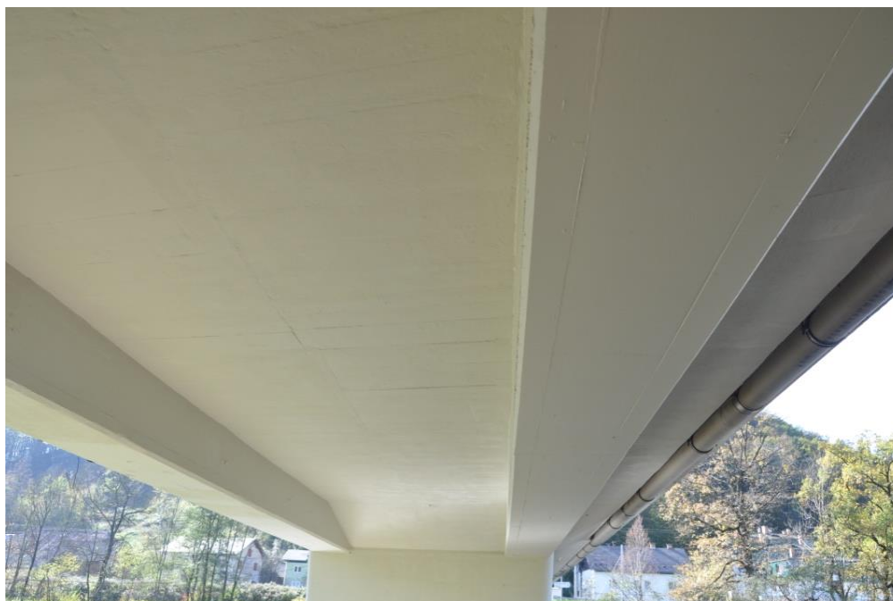
Slika 24: Zaščita betona 1 (lasten vir)
