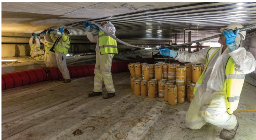
Slika 13: Lepljenje karbonskih lamel (Sika, 2016)
