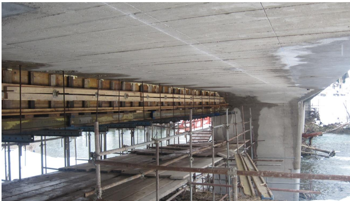
Slika 21: Opaž nosilca (lasten vir)
