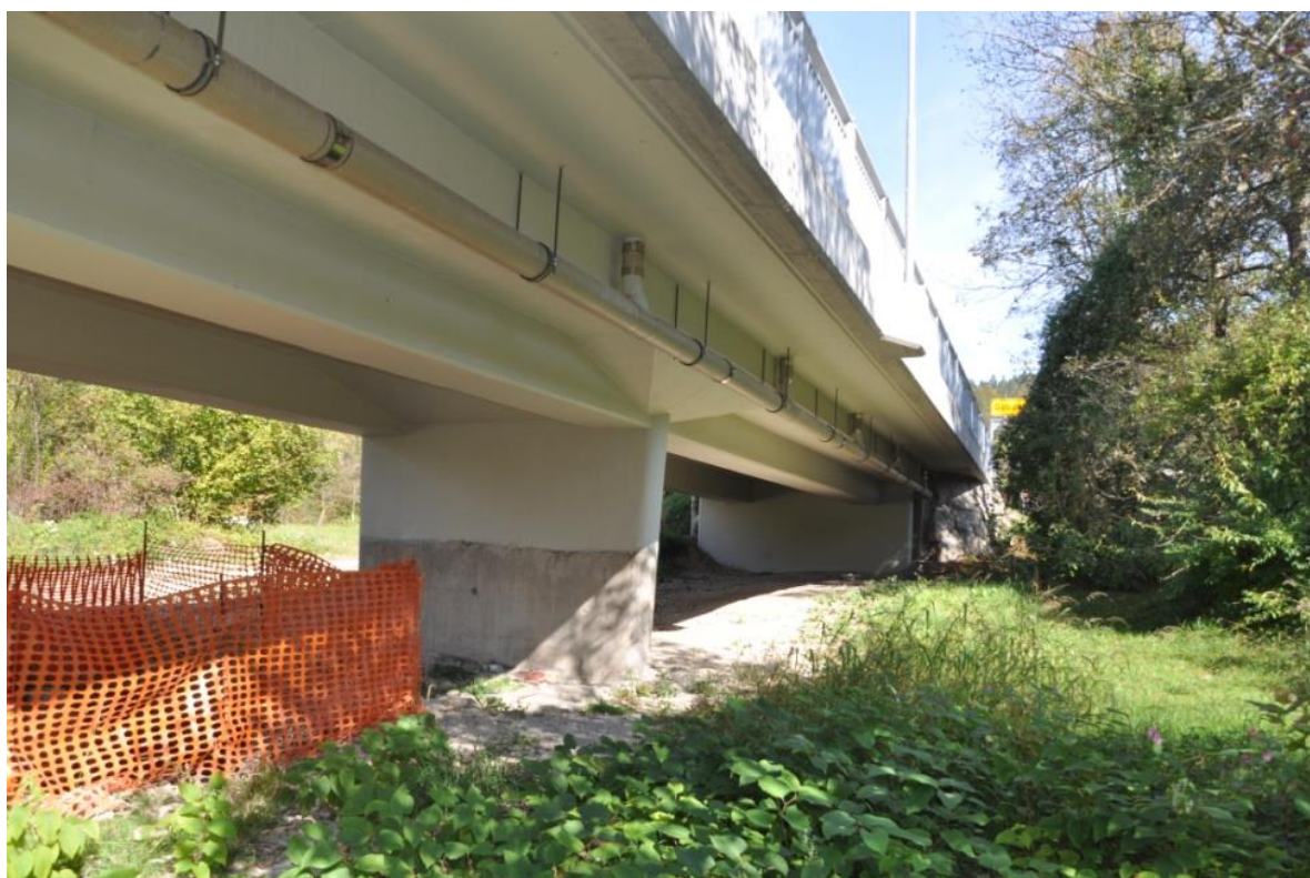
Slika 26: Zaščita betona 3 (lasten vir)
