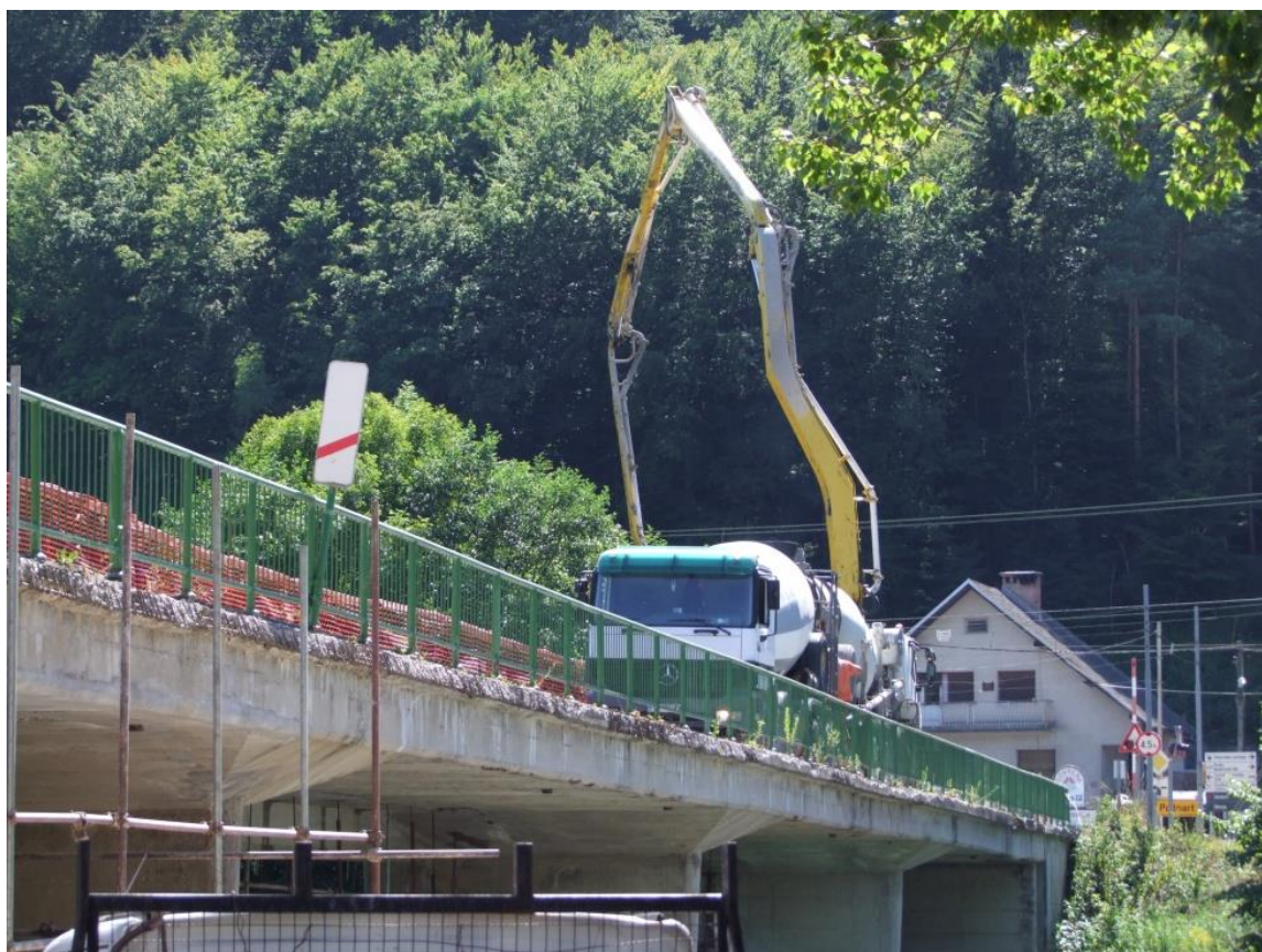
Slika 22: Betoniranje nosilcev (lasten vir)
