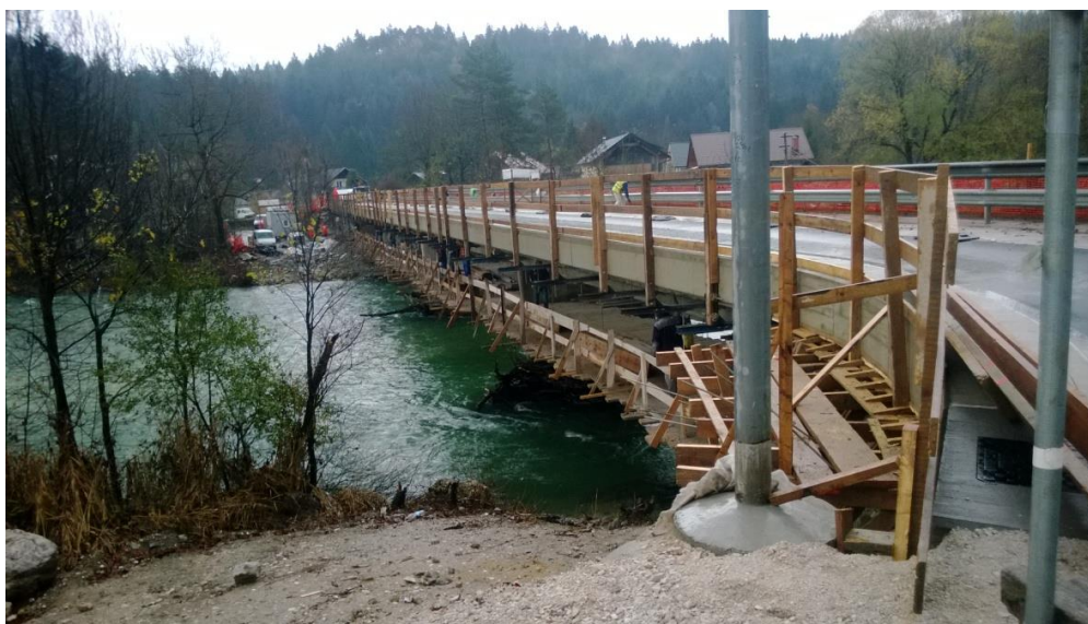
Slika 23: Oder za izdelavo zaščitnega premaza (lasten vir)
