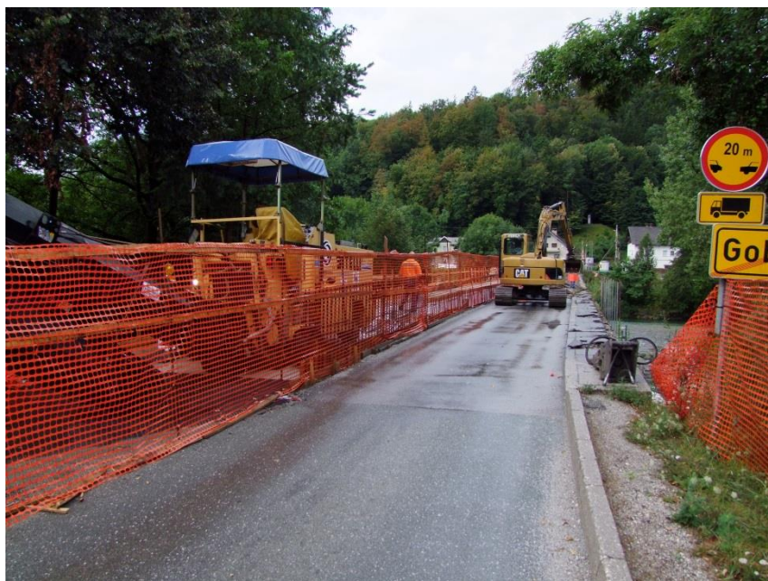
Slika 16: Odstranjevanje asfalta in hidroizolacije (lasten vir)
