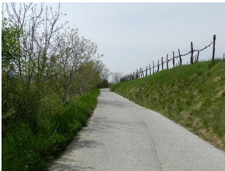
Slika 19: asfaltirana lokalna cesta.
