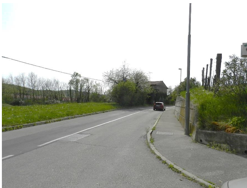
Slika 10: pogled na vozišče v začetku trase.
