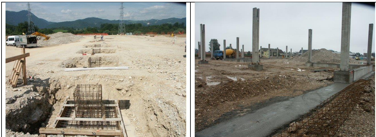
Slika 8: Izgradnja temeljev in nosilnih stebrov objekta
