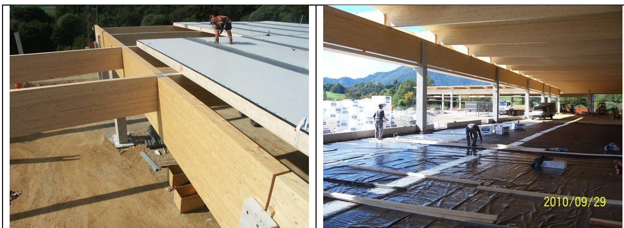
Slika 10: Gradnja strešne konstrukcije in polaganje izolacije pod ploščo
