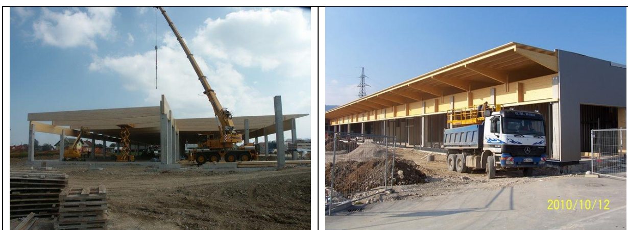
Slika 9: Nosilna konstrukcija objekta
