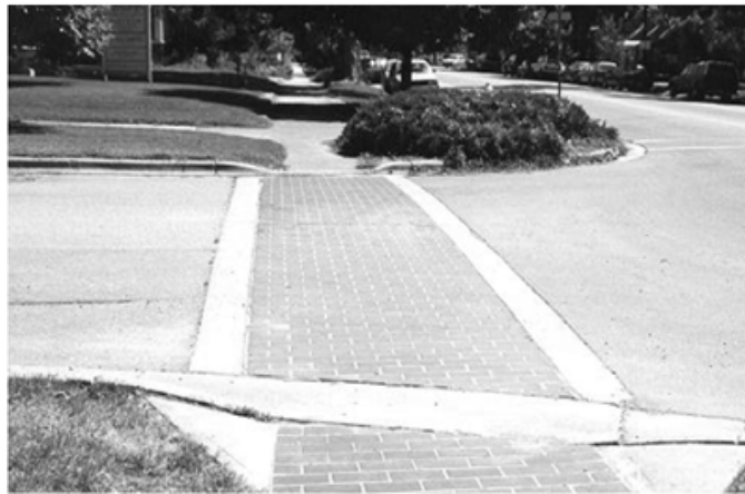
Dvignjeni prehod za pešce (vir: www.trafficcalming.org )
