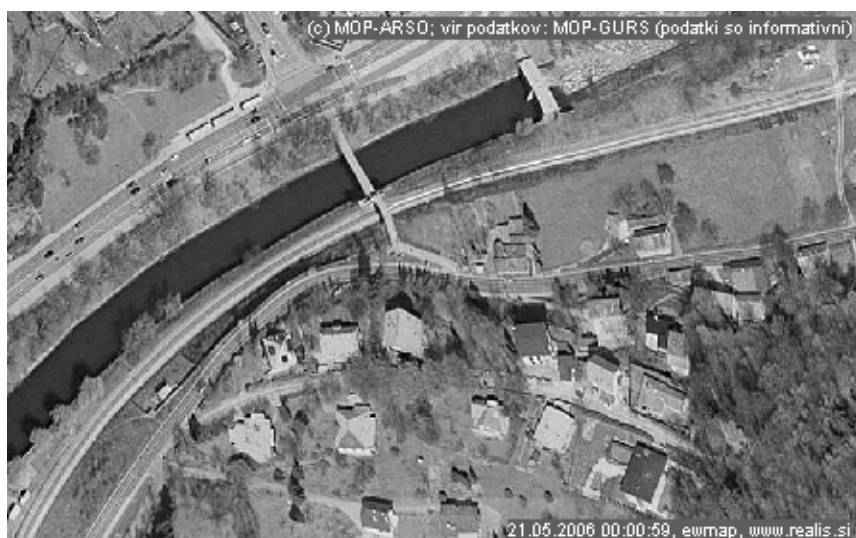
Slika 5.1: Obstoječe stanje na Hrdeckega ulici
