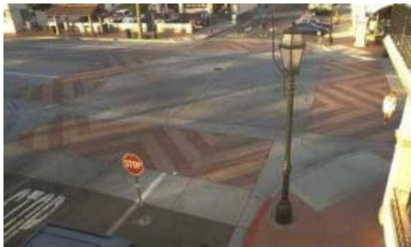
Sprememba teksture vozišča (vir: http://safety.fhwa.dot.gov/ )
