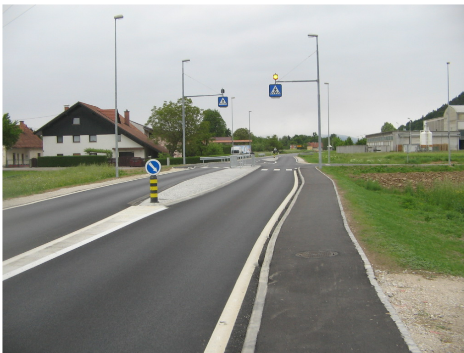
Slika 5.23: Slika 4; Prevelik polmer osi
