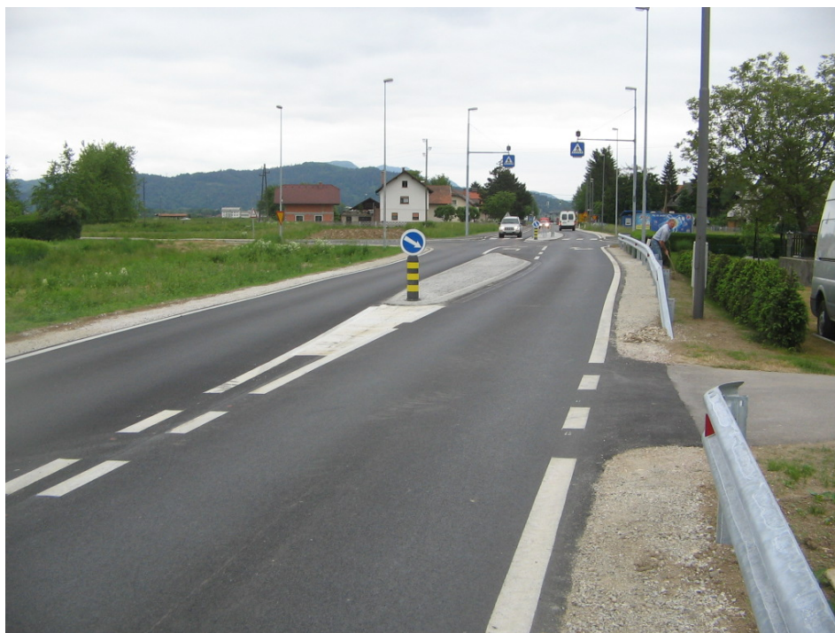
Slika 5.20: Slika 1; Prevelik polmer osi
