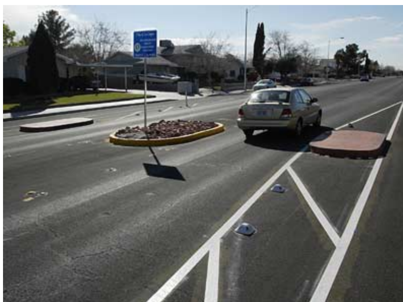
Zoženje vozišča z uporabo sredinskega in stranskega otoka (vir: www.trafficcalming.org )
