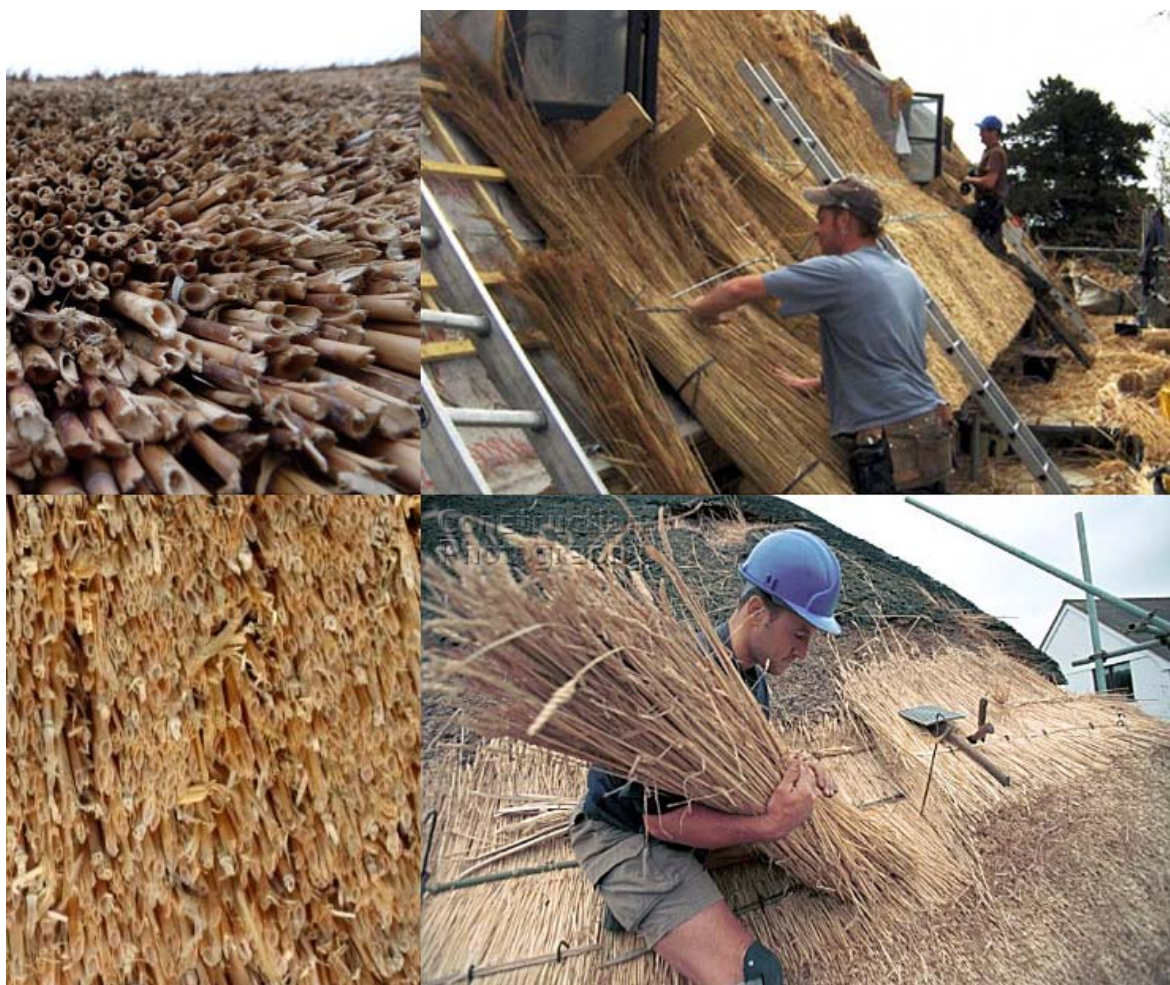
Slika 5: Primerjava v strukturi in dolžini stebel med trsjem (zgoraj) in pšenično slamo (spodaj) (South West Thatching, Water reed (Norfolk reed) thatching)
