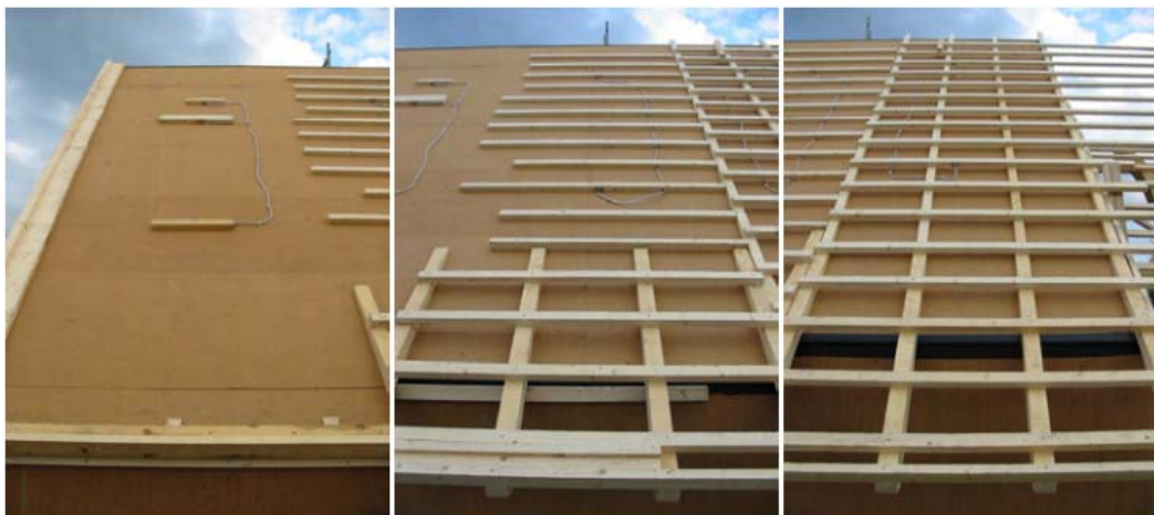
Slika 20: Priprava strehe za požarni test s tremi testnimi območji (Realbrandversuch, „Regionalhaus aus 100% nachwachsenden Rohstoffen“, 2009)
