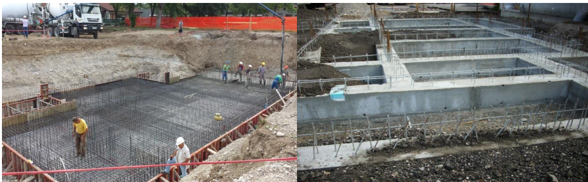
Slika 6: Izvedba AB del – betoniranje temeljne plošče zaklonišča (levo) in pasovni temelji pritličnega dela objekta (desno)
