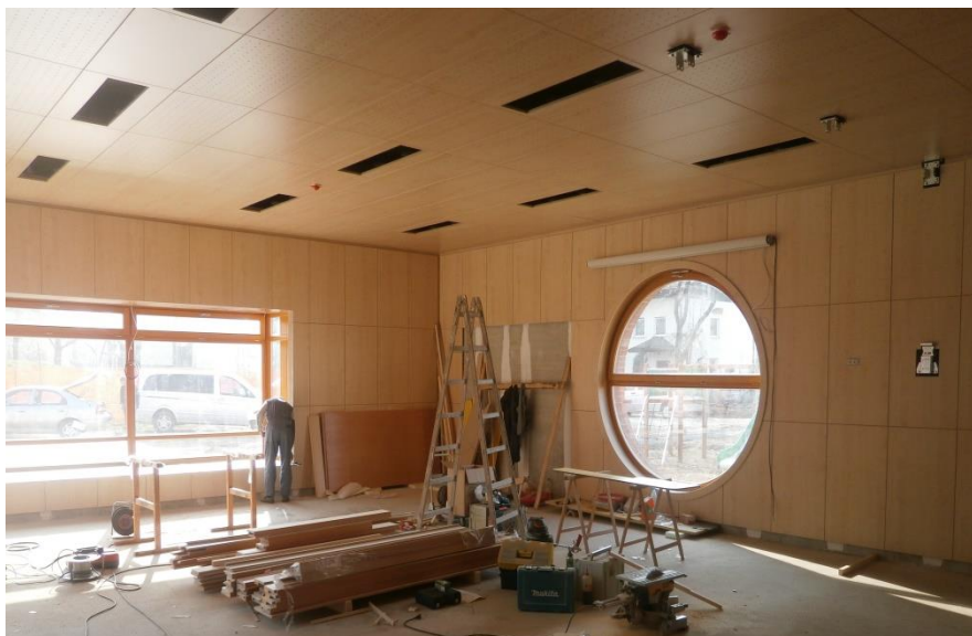
Slika 7: Notranjost objekta (telovadnica) med izvedbo obrtniških del
