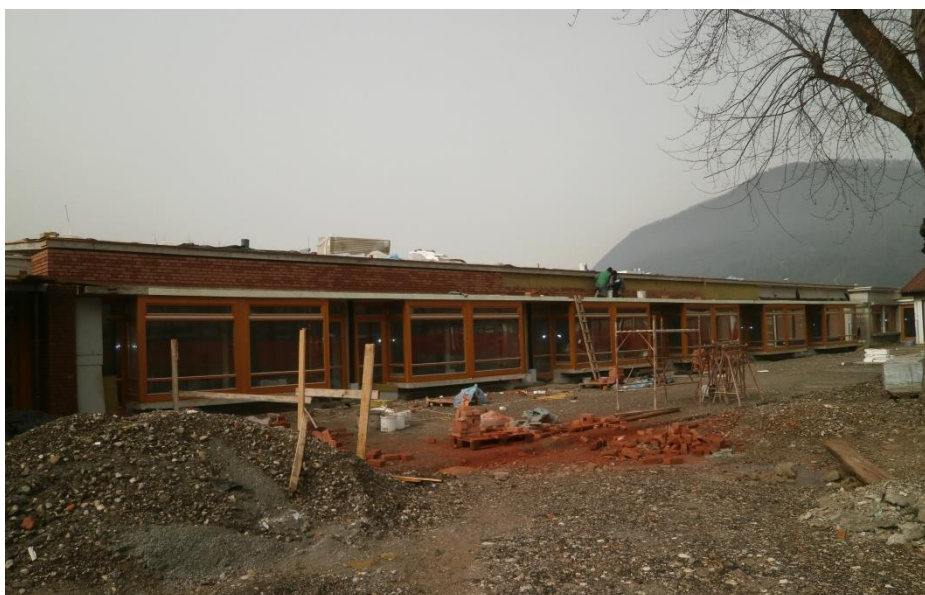
Slika 8: Zunanost objekta med izvedbo fasaderskih del
