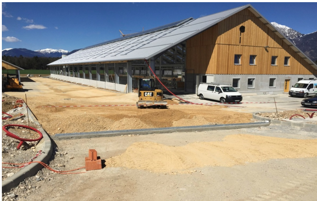
Slika 27: Priprava utrjenega nasutja pod asfaltom
