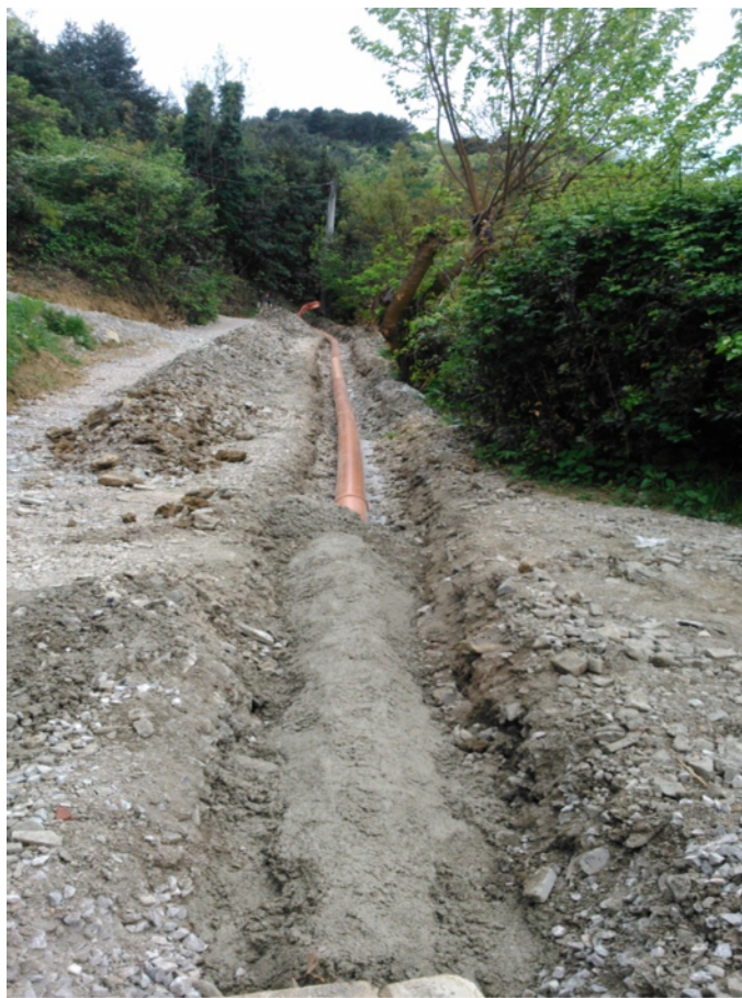
Slika 23: Slika prikazuje izkop ozkega jarka za izdelavo komunalnih vodov
