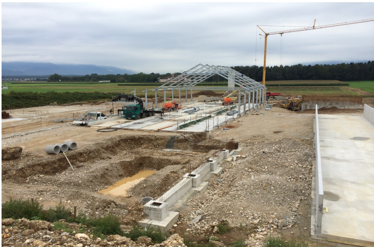
Slika 35: Prikaz montaže jeklene konstrukcije hleva
