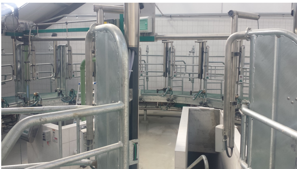
Slika 10: Molzišče tipa rotolaktor
