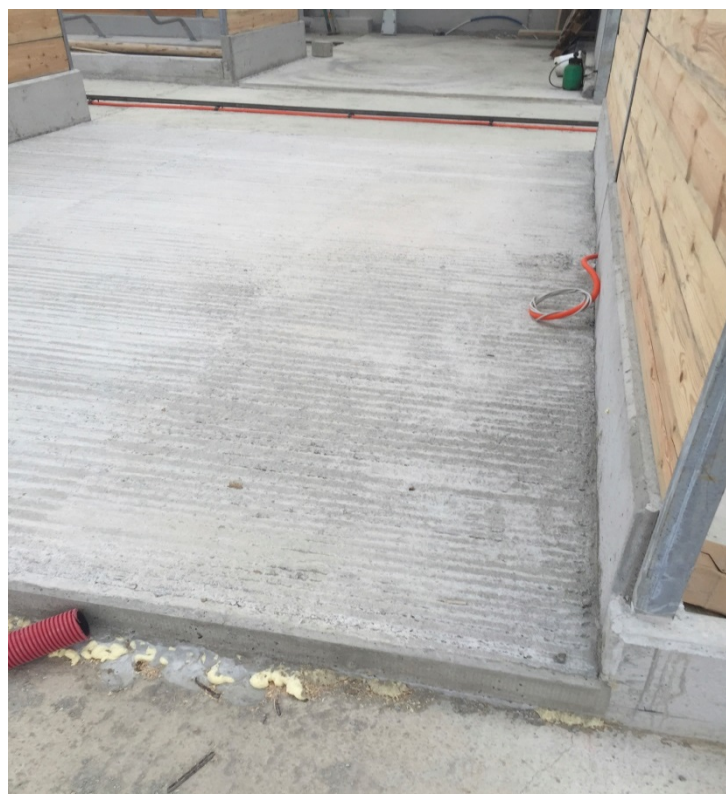
Slika 32: Nedrseča rampa za nivojski prehod v hlevu
