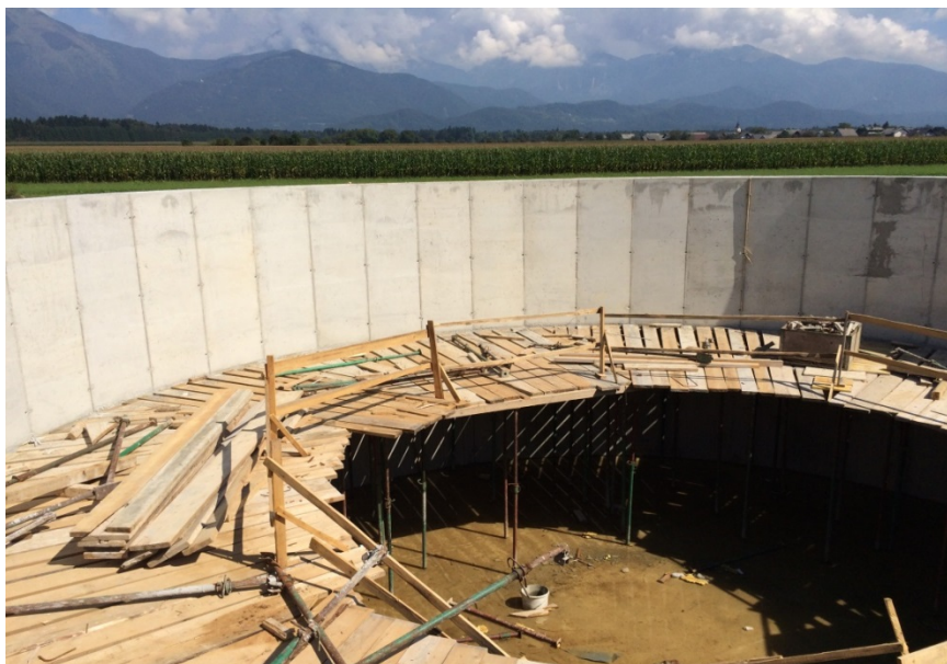
Slika 33: Primer delovnega odra in zaščitne ograje v laguni, ki služi za opaževanje in betoniranje stene lagune
