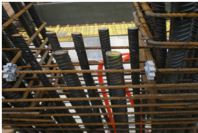
Slika 28: Primer PVC distančnika za zagotavljanje predpisane krovne plasti betona na stebru
