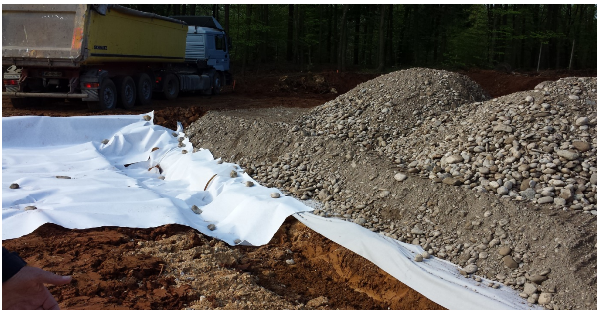
Slika 24: Na sliki je prikazano, kako se izboljšujejo temeljna tla s tamponsko blazino
