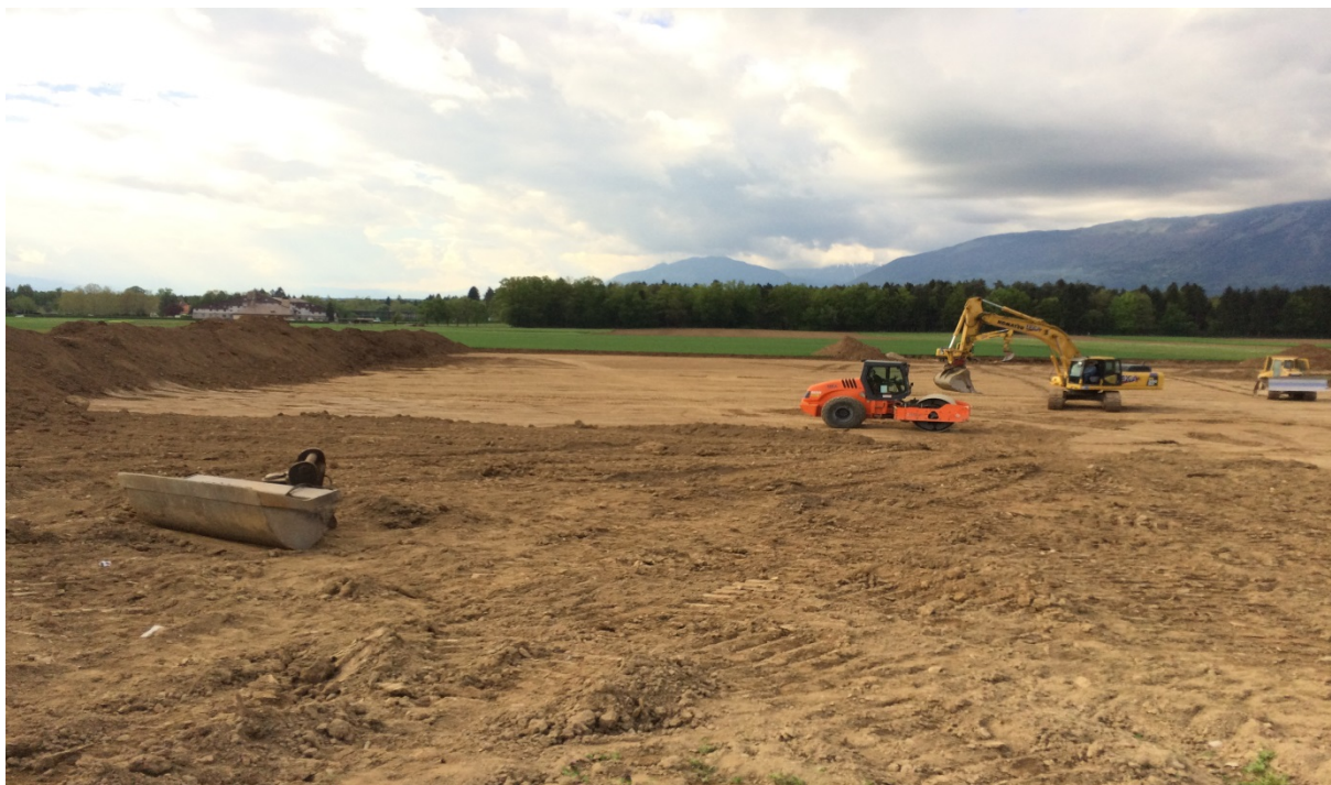
Slika 22: Slika prikazuje odriv humusa
