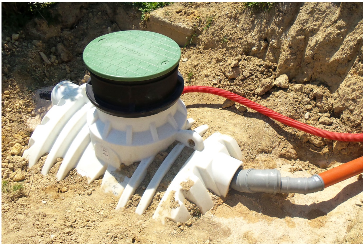
Slika 39: Vgradnja čistilne naprave
