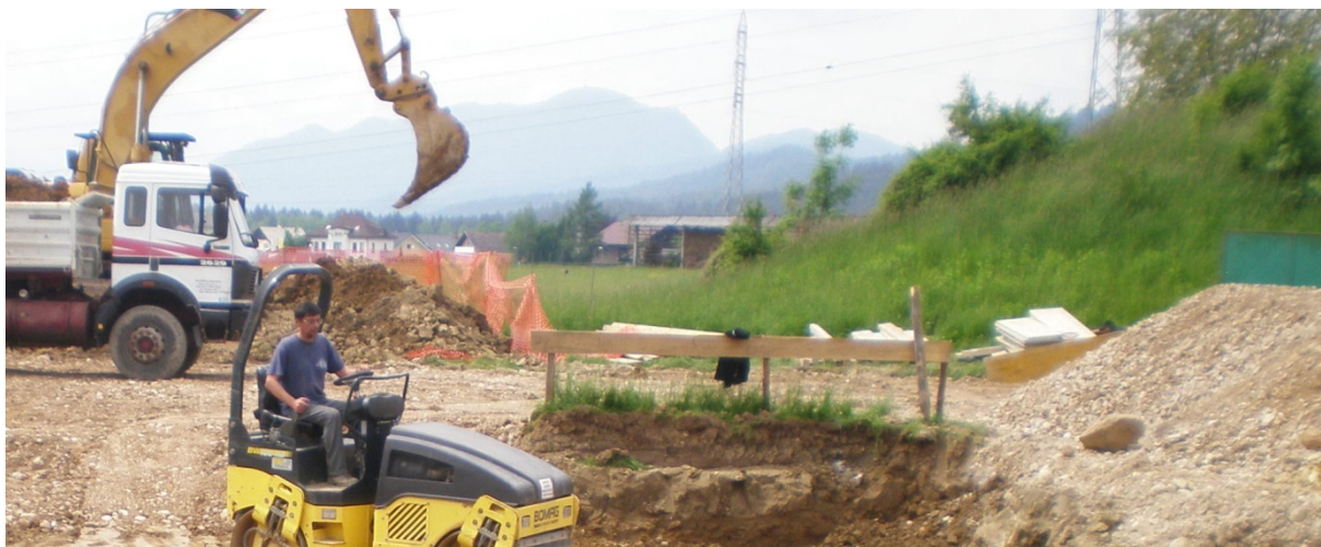
Slika 21: Primer zakoličbenega profila, ki označuje zunanji vogal pritličja objekta
