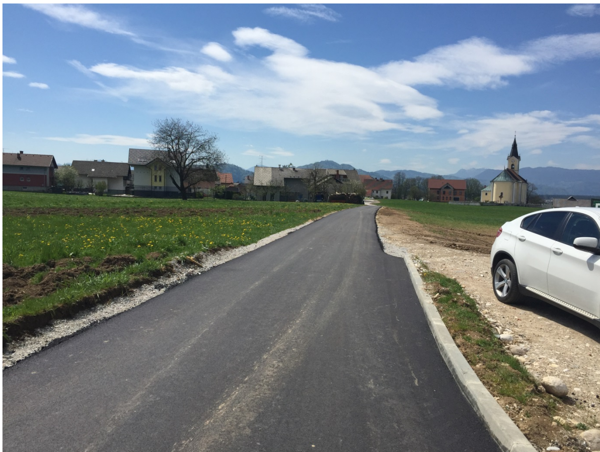
Slika 38: Zgrajena dovozna cesta
