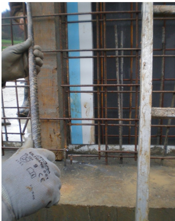
Slika 30: Slika prikazuje, kako so vgrajeni kovinski trakovi za vodotesnost betonske konstrukcije
