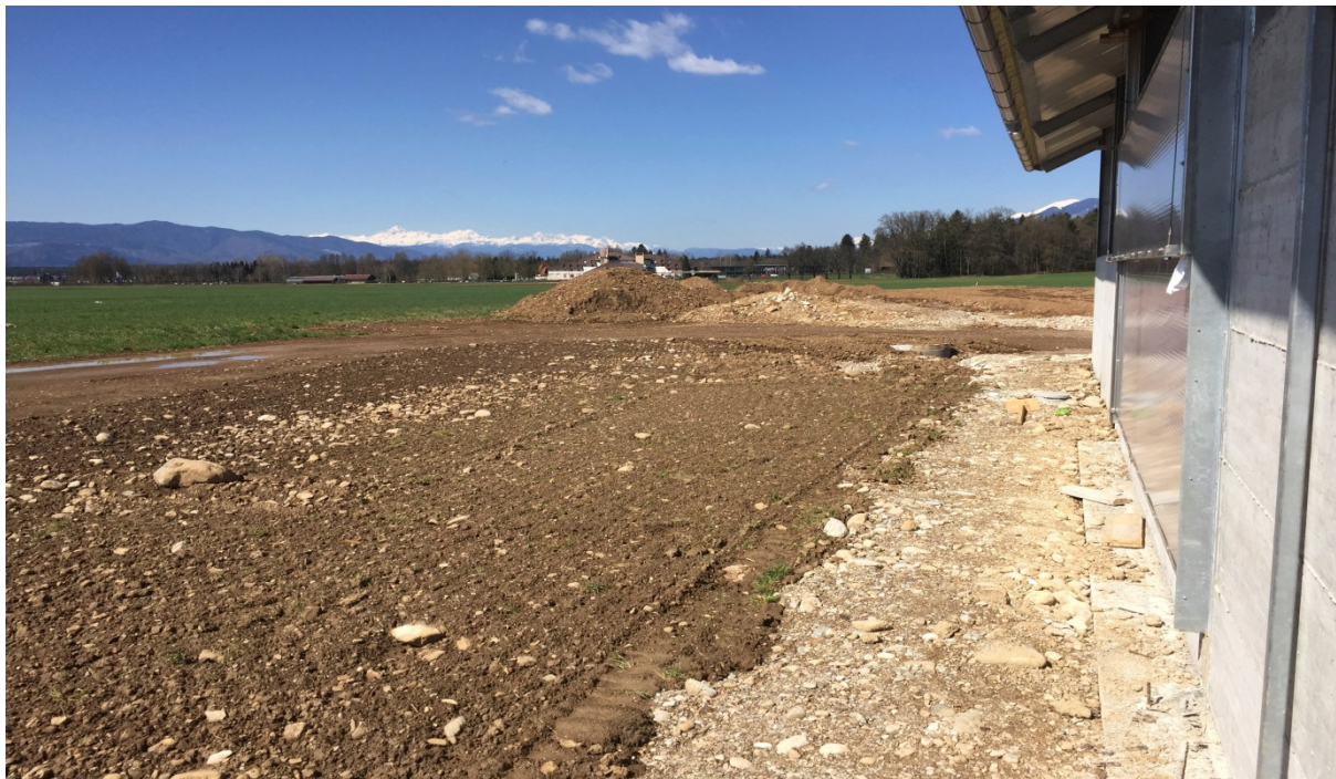
Slika 26: Zasip za objektom
