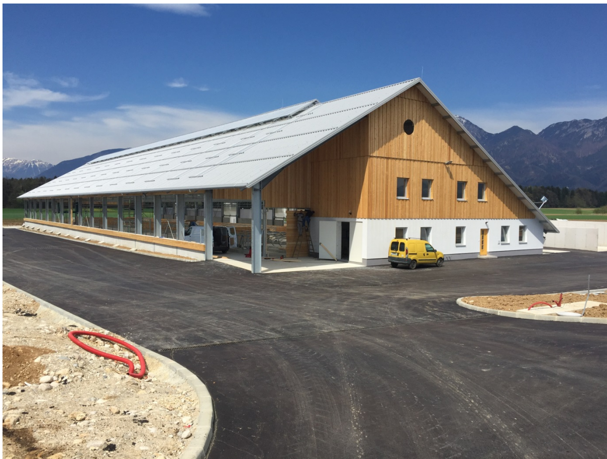
Slika 34: Na sliki je fasada izdelana v kombinaciji lesene obloge iz macesnovih desk in zaključnega mineralnega ometa
