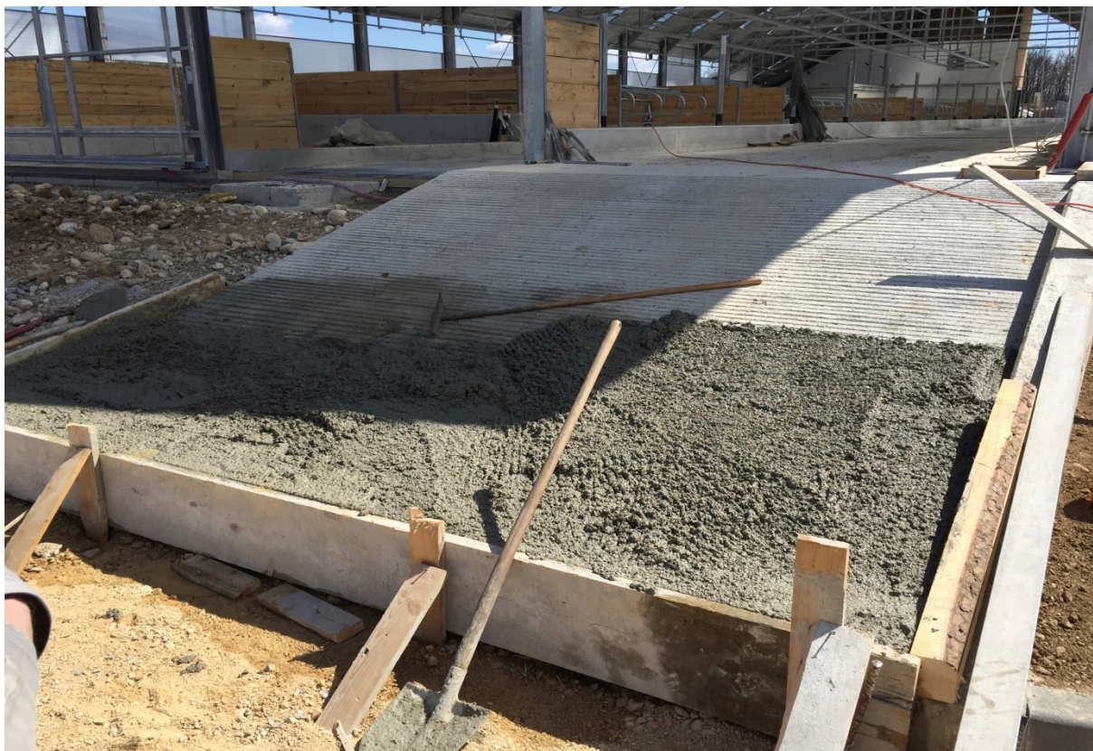
Slika 31: Slika prikazuje izdelavo nagrbnčene betonske rampe
