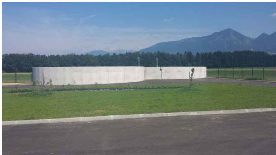
Slika 12: Armiranobetonski laguni za gnojevko
