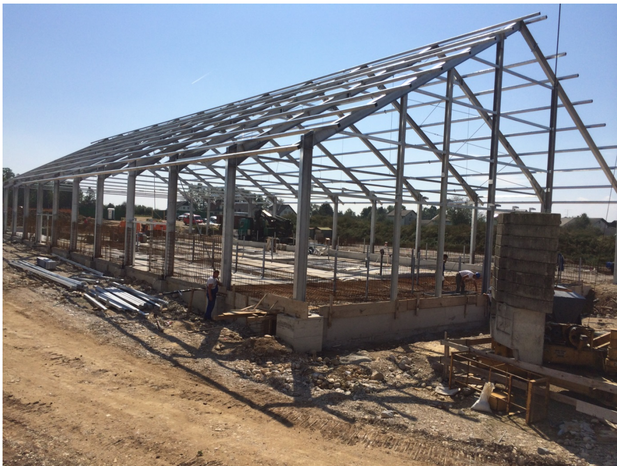
Slika 36: Izdelana jeklena nosilna konstrukcija objekta
