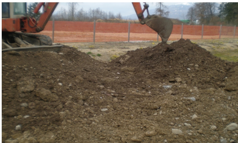
Slika 16: Na sliki je prikazano gradbišče ograjeno s PVC ograjo
