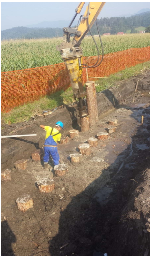
Slika 25: Slika prikazuje temeljenje s pomočjo lesenih kostanjevih pilotov
