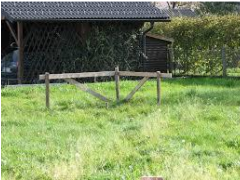
Slika 13: gradbeni profil (vir: http://www.podsvojostreho.net/ )
