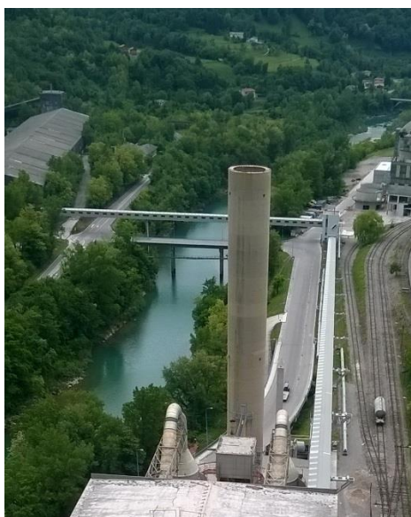
Slika 27: Mesto izpusta dimnih plinov [Vir: lasten]
