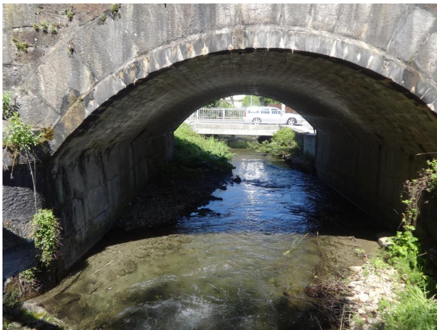
Slika 18: Cestni in železniški prepust (foto: M. Lang)
