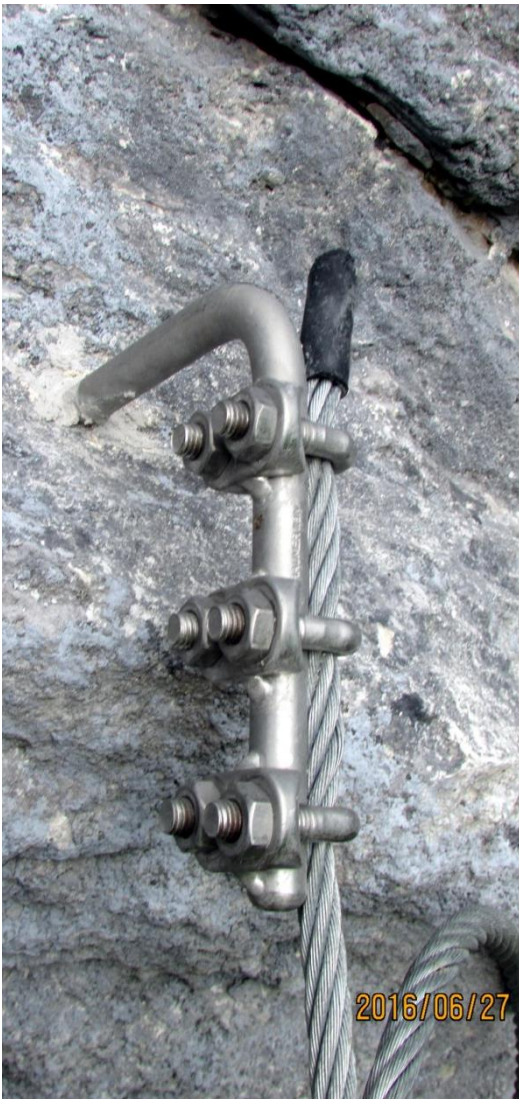
Slika 21: Dve različni izvedbi končnega sidra in dve različni izvedbi zaključnih kap,
