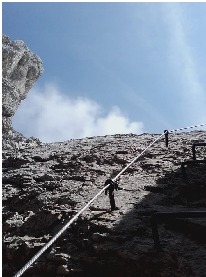
Slika 11: Prednapeti jekleni sistem v slovenskih gorah.
