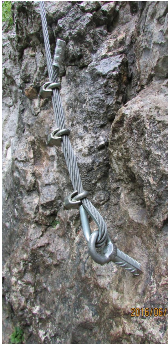
Slika 21: Dve različni izvedbi končnega sidra in dve različni izvedbi zaključnih kap,
