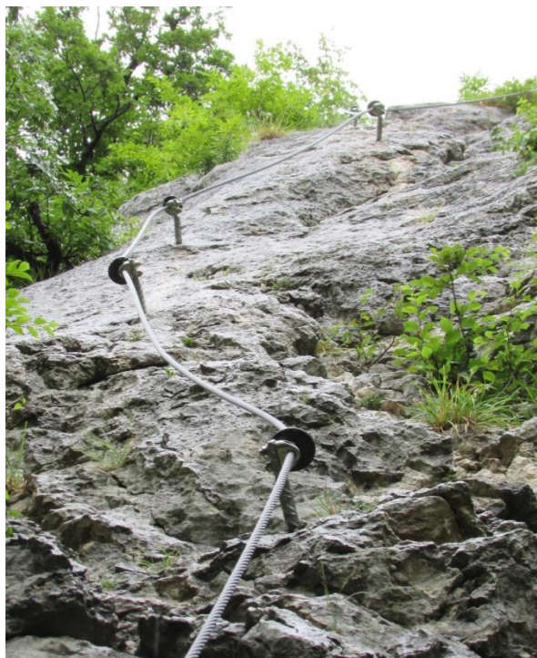
Slika 9: ferata v Gonžarjevi peči, ki je narejena po tirolskem načinu gradnje.
