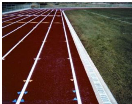
Slika 29: Peščeni drenažni sistem ob tekaški progi (Sports Turf Managers Association, 2016)
