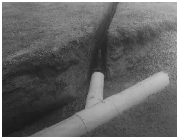
Slika 32: Navpični drenažni kanali so povezani z zbiralnim kanalom, ki omogoča odtekanje vode stran od igrišča. (Puhalla in sod., 2010)
