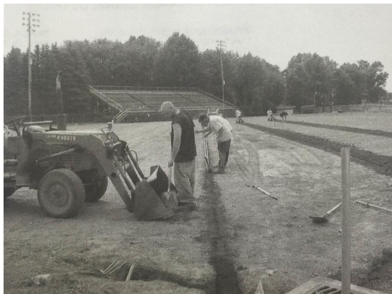
Slika 31: Delavci nameščajo navpični drenažni sistem. Pomemben korak pri zagotavljanju ustreznega delovanja je ohranitev navpičnosti drenažnega kanala v središču jarka, kar na sliki počne delavec v ozadju. (Puhalla in sod., 2010)
