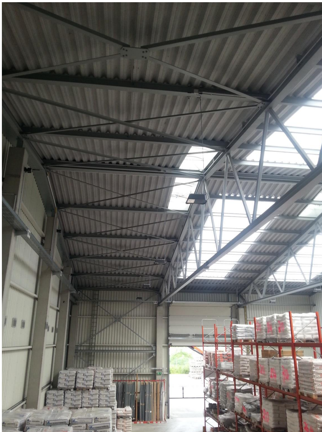
Slika 26: Skladišče gradbenega materiala. [4]
