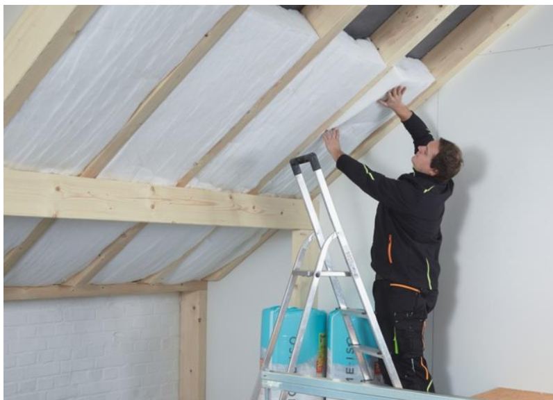
Slika 18: Vgradnje netkane tekstilije kot toplotna izolacija podstrešja. [10]
