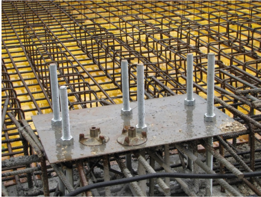
Slika 14: Priprava za kasnejšo montažo primarne jeklene konstrukcije
