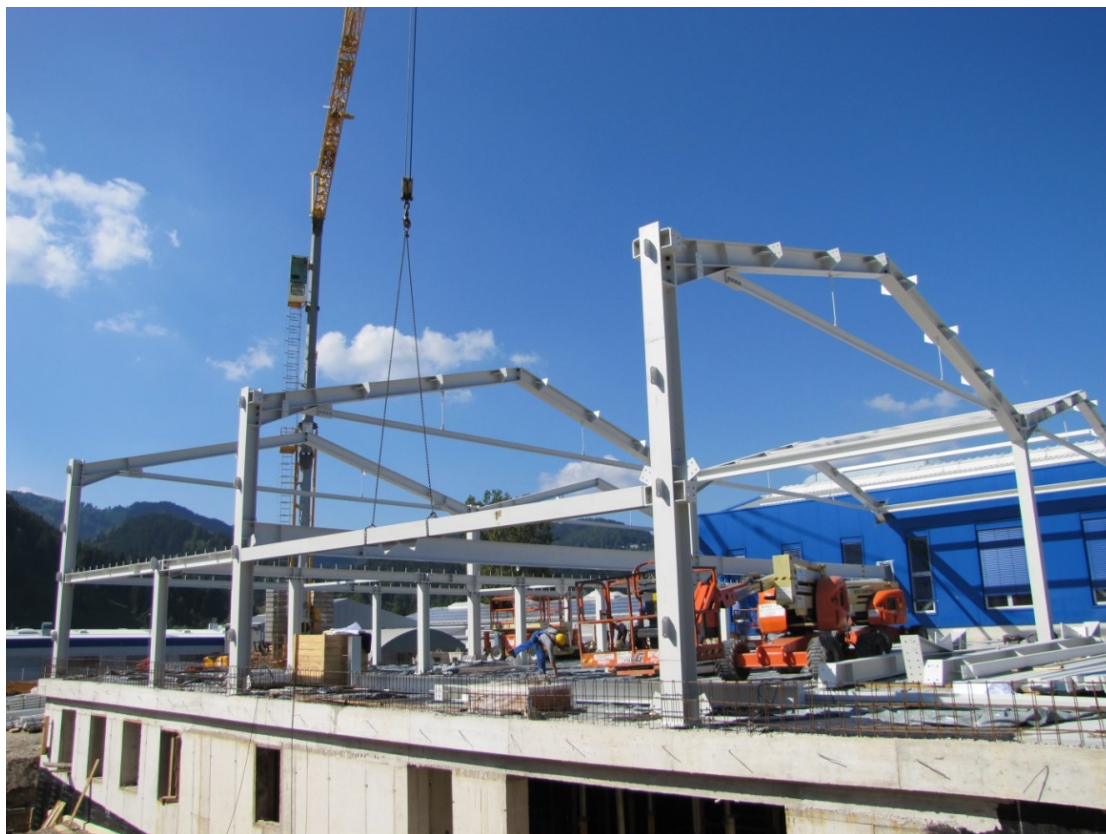
Slika 11: Montaža primarne jeklene konstrukcije
