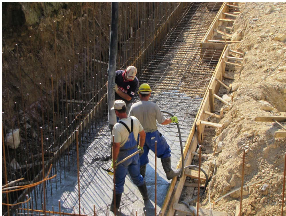
Slika 22: Betoniranje temeljev podpornega zidu
