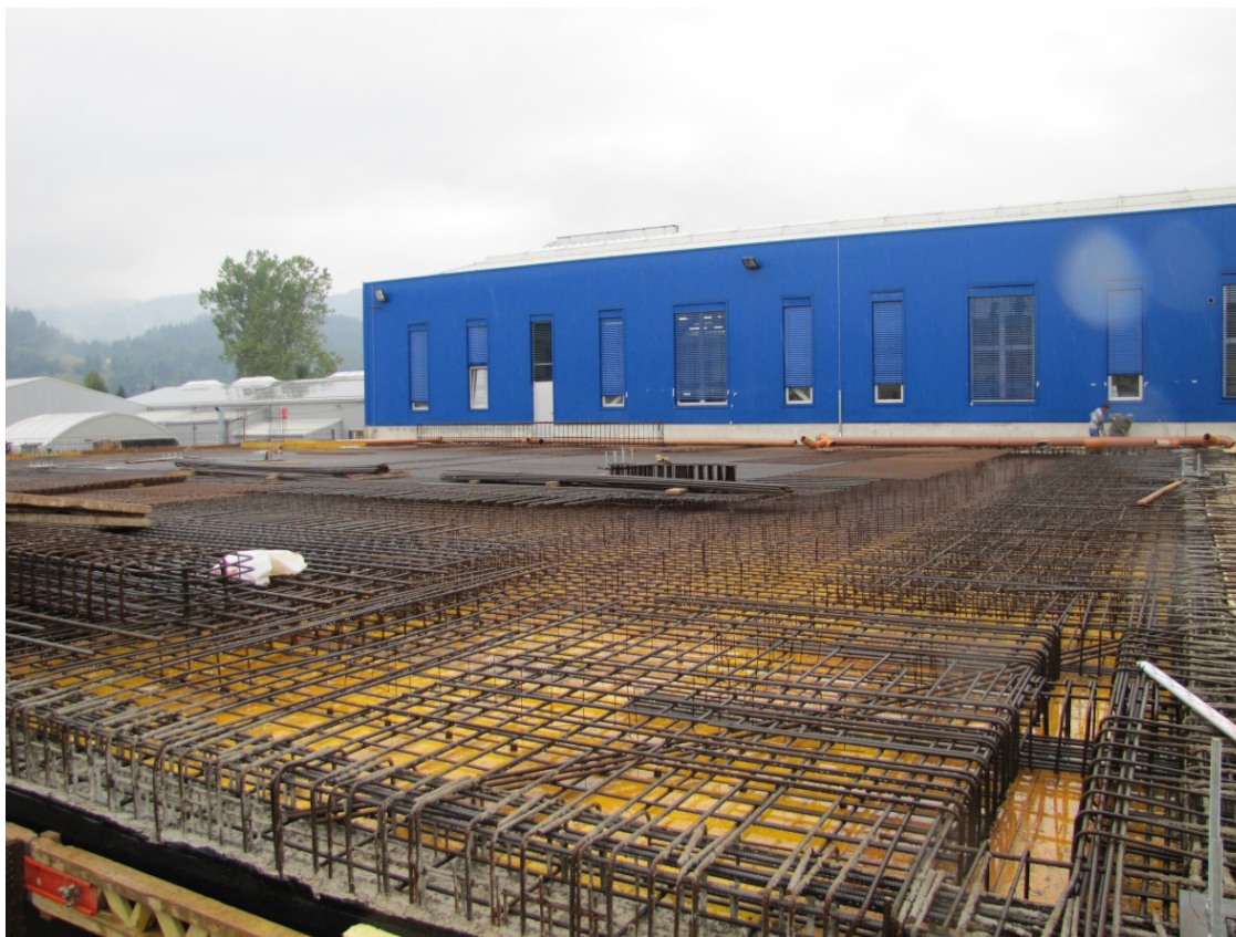
Slika 21: Polaganje in vezanje armature
