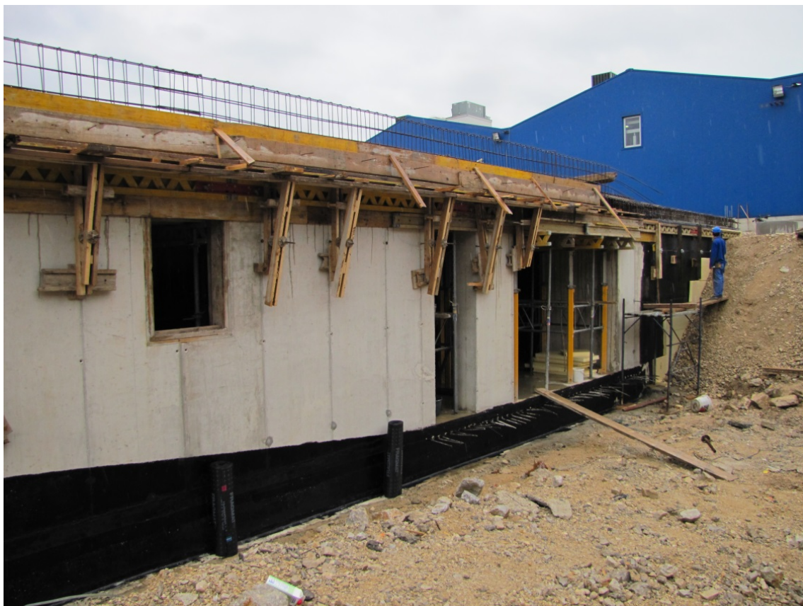
Slika 17: Izdelava hidroizolacije in opaževanje roba plošče
