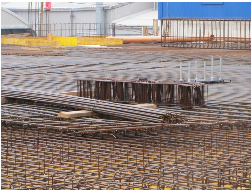
Slika 13: Polaganje armature za nosilno ploščo
