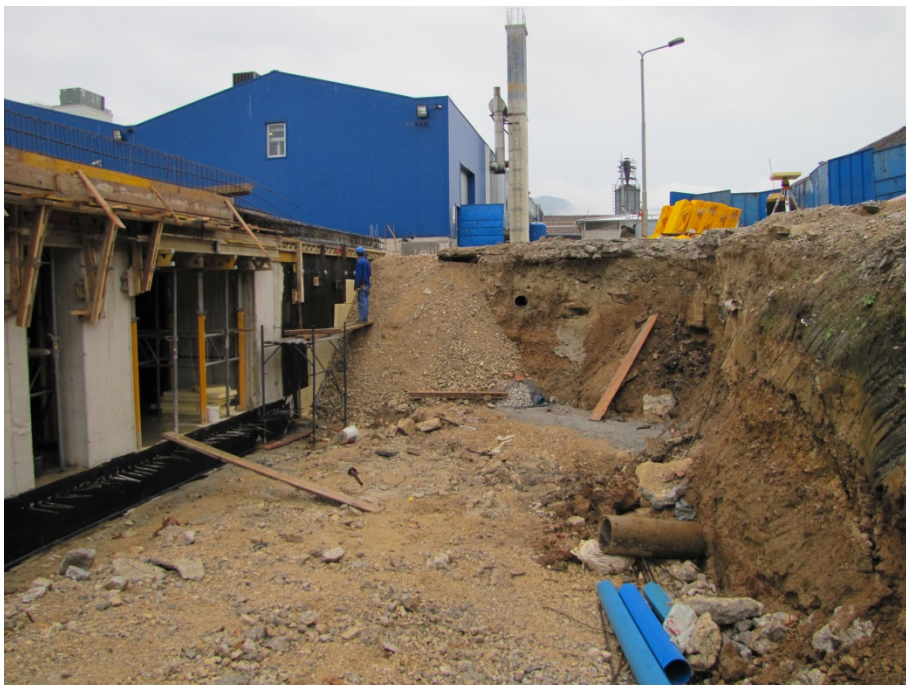
Slika 15: Izkop za dovodno pot in za temelje podpornih zidov
