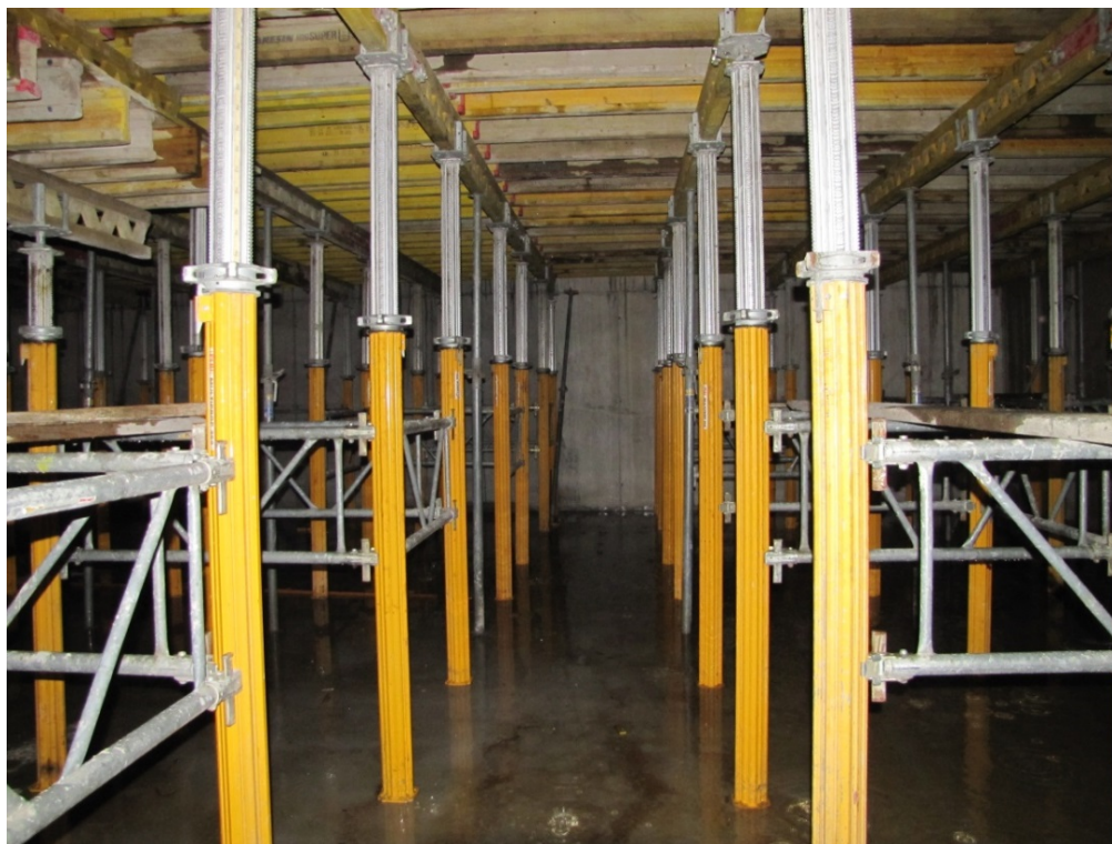
Slika 12: Opaž nosilne plošče pred betoniranjem.
