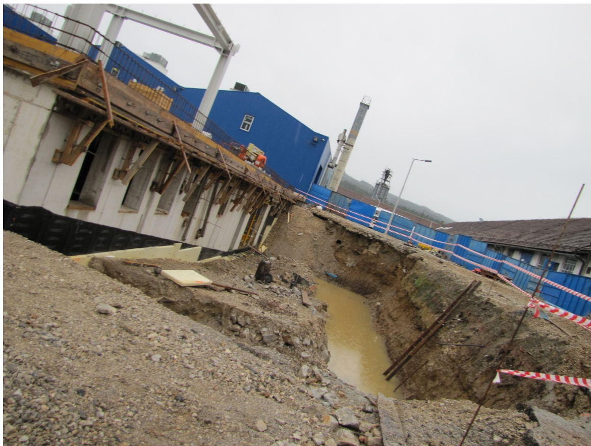
Slika 18: Udor podzemne vode
