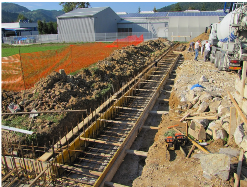
Slika 23: Betoniranje temeljev podpornega zidu za parkirišče
