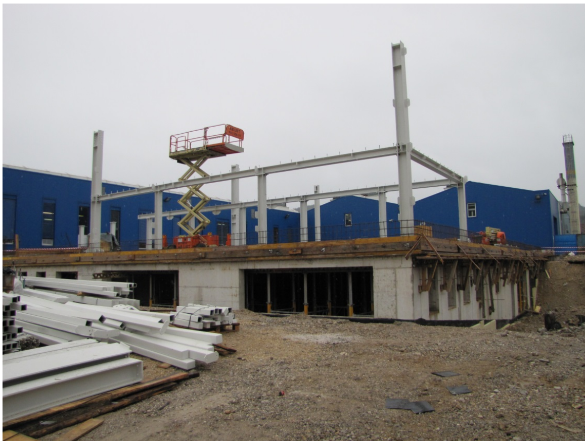
Slika 20: Začetek montaže jeklenih stebrov primarne jeklene konstrukcije
