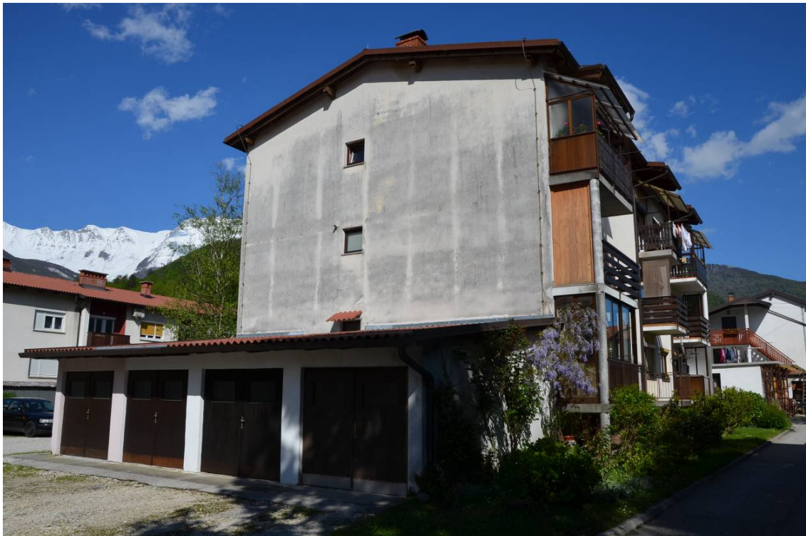
Slika 6: VS v Občini Kobarid, zgrajena leta 1975, z obnovljeno streho leta 2009 [9]
