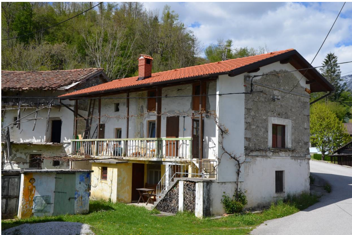
Slika 5: Kamnita hiša v naselju Logje, zgrajena leta 1800, z obnovljeno streho [9]
