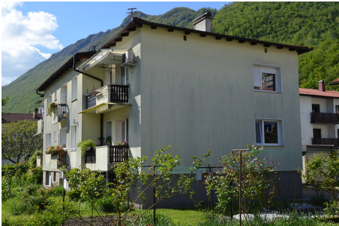
Slika 7: VS v Občini Kobarid, zgrajena leta 1963, leta 2006 obnovljena streha, leta 2007 obnovljena fasada [9]
