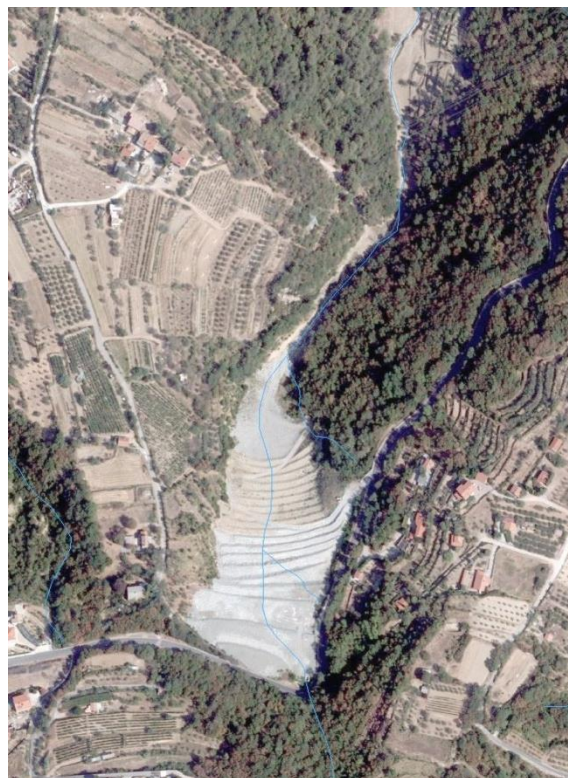
Slika 20: Digitalni ortofoto posnetek deponije v izvedbi
