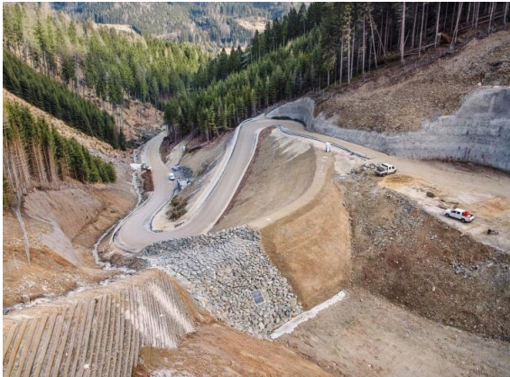
Slika 37: Osnovni nasip ob vznožju deponije Figure 37: General embankment at the foot of landfill
