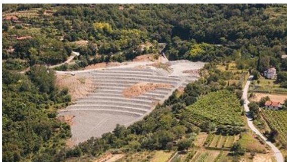
Slika 23: Pogled na deponijo Šared leta 2011 Figure 23: View on the landfill Šared in the year 2011 (vir: http://www.primorske.si/Primorska/Istra/Koncno-dovolilnice-za-prevoze-na-deponijo-Sared.aspx , 2015)
