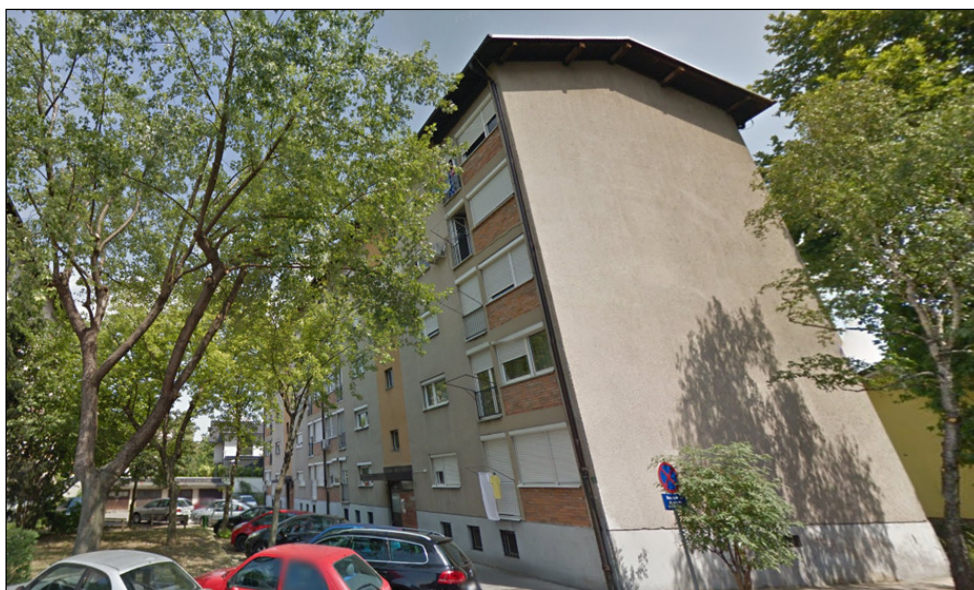
Slika 18: Obravnavana stavba; pogled na zahodno in južno fasado (Vir: GoogleEarth)
