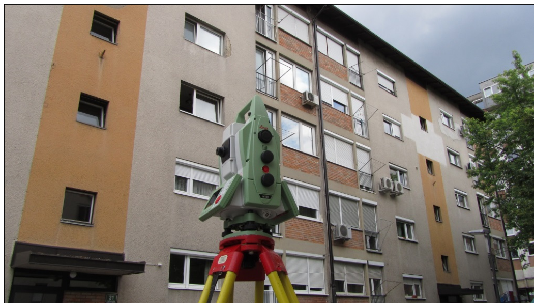
Slika 25: Obravnavana stavba; pogled na zahodno fasado
