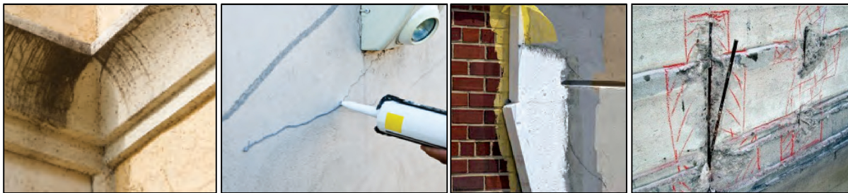
Slika 4: Načini sanacij fasad po prej opisanem vrstnem redu [30]
