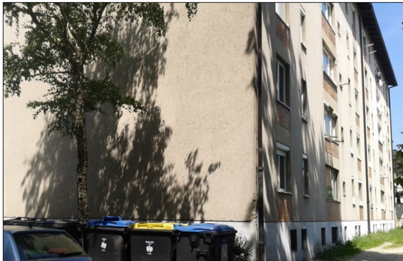
Slika 19: Obravnavana stavba; pogled na južno in vzhodno fasado
