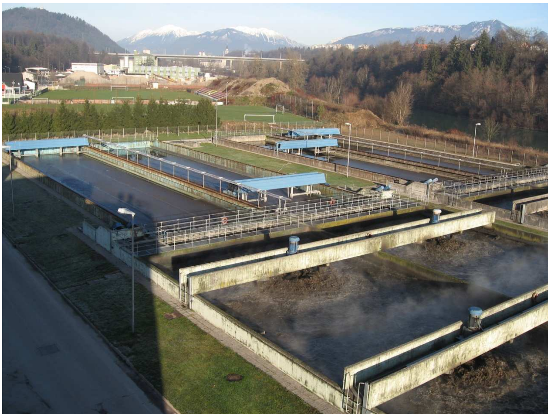
Slika 4: Aeracijski bazeni in naknadni usedalniki na CČN Kranj
