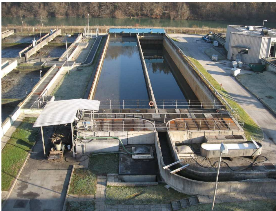
Slika 3: Primarna usedalnika na CČN Kranj
