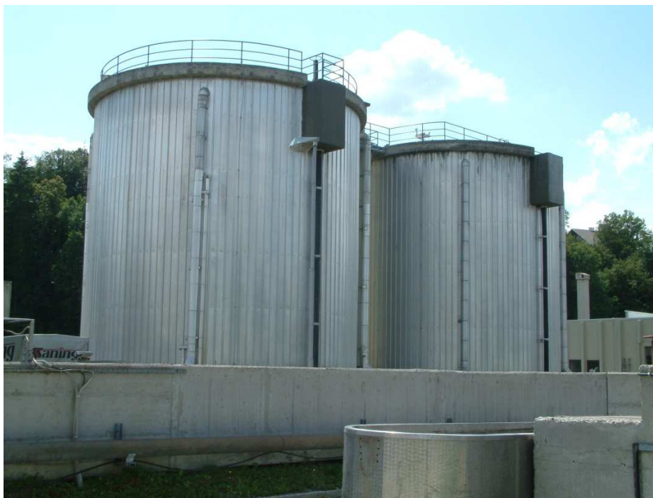
Slika 5: Primarno in sekundarno gnilišče na CČN Kranj
