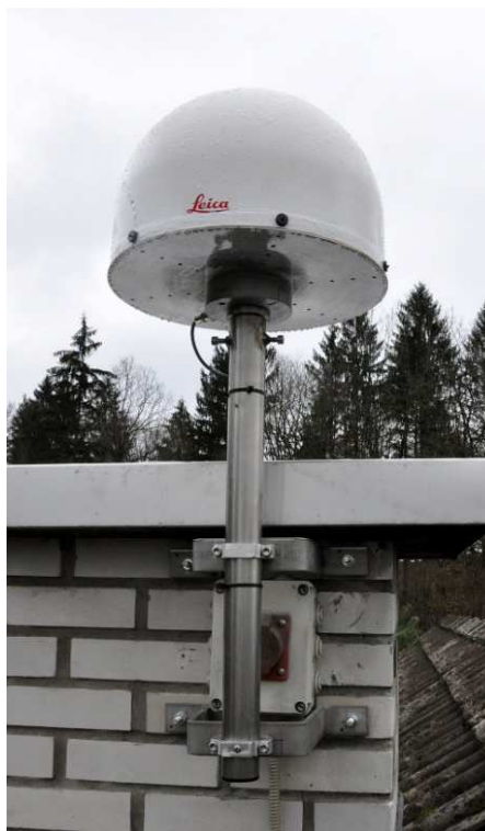
Slika 20: Nameščena antena z dušilnimi obroči Leica AT504
