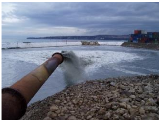
Slika 24: Refuliranje kasete (Battelino, 2009)
