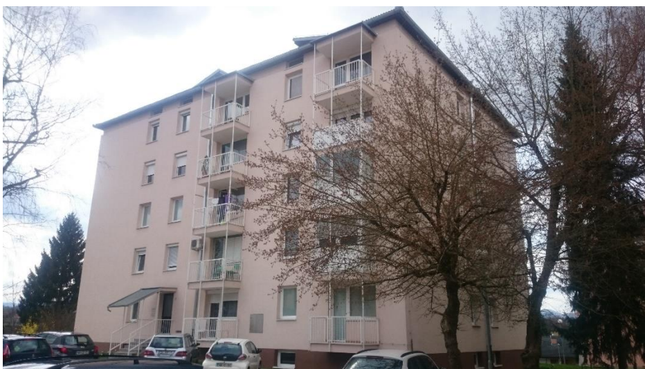
Slika 1: Večstanovanjska stavba na Smrečnikovi ulici 30
