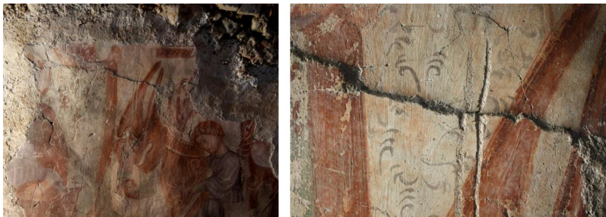
Slika 2.7: Godešič, cerkev sv. Miklavža, odstopanje ometa od zidu zaradi potresa in prezidav v preteklosti. Valovita površina stenske slike (levo) in detajl nivojske razpoke zaradi odstopljenega ometa od zidu (desno) (Kavčič, 2015).
