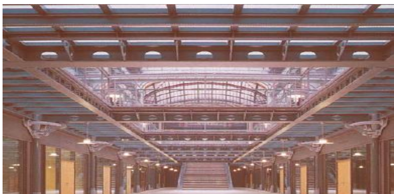
Slika 18.2: Uporaba satastih nosilcev za moderniziranje starih zgradb (ACB Cellular Beams)
