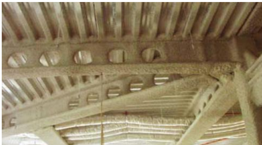
Slika 6.1: Zaščita satastega nosilca z brizganim intuscementnim premazom (Mitchell in sod., 2003)
