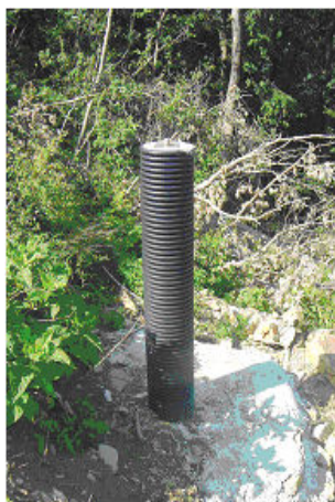
Slika 18: Opazovalni betonski steber 5012
