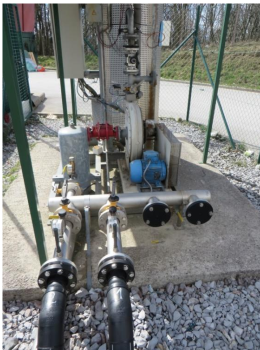
Slika 18: Merilno mesto za merjenje emisij plinov (foto: Barbara Corn)
