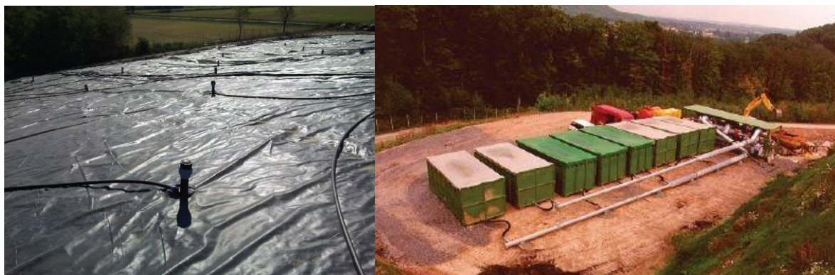
Slika 35: Namestitev prezračevalnega sistema in biofiltrskih naprav [6]
