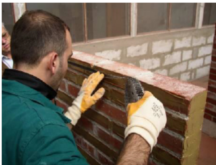
Slika 26: Nanos lamelne traku ( http://www.gi-zrmk.si/ )
