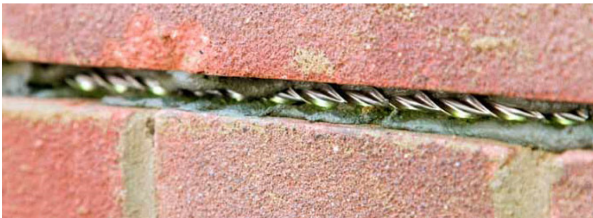
Slika 25: Vgradnja svedraste palice ( www.helifix.com )
