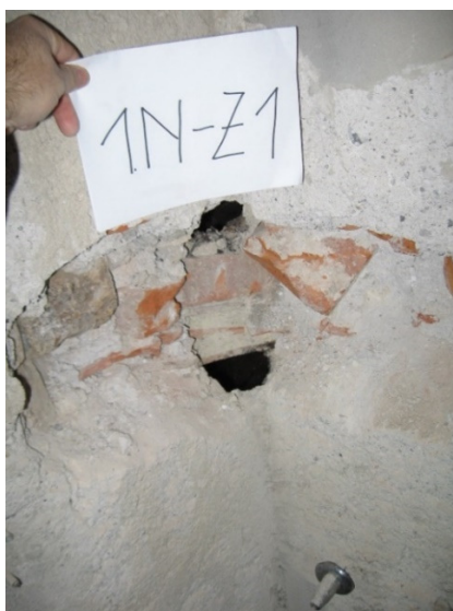
Slika 2: Zidna sonda 1. nadstropja na mestu dimniške tuljave (ZRMK 2007)
