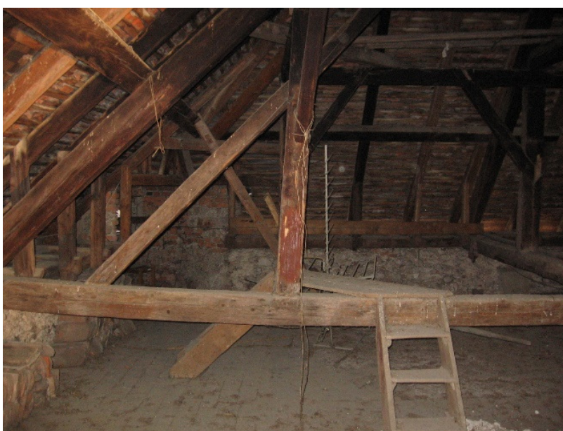
Slika 10: Deformirani elementi (ZRMK 2007)
