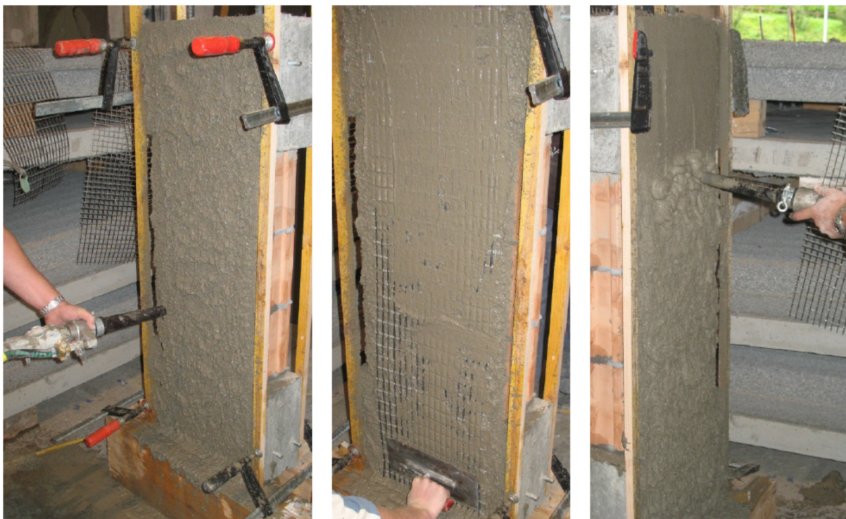
Slika 24: Postopek oblaganja z mrežico iz ogljikovih vlaken (Retrofitting Masonry Walls with Carbon Mesh)
