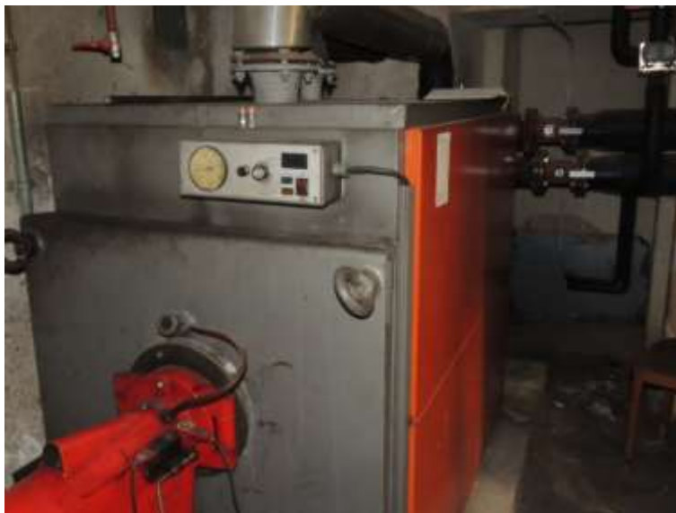
Slika 69: Vgrajeni oljni kotel z gorilnikom
