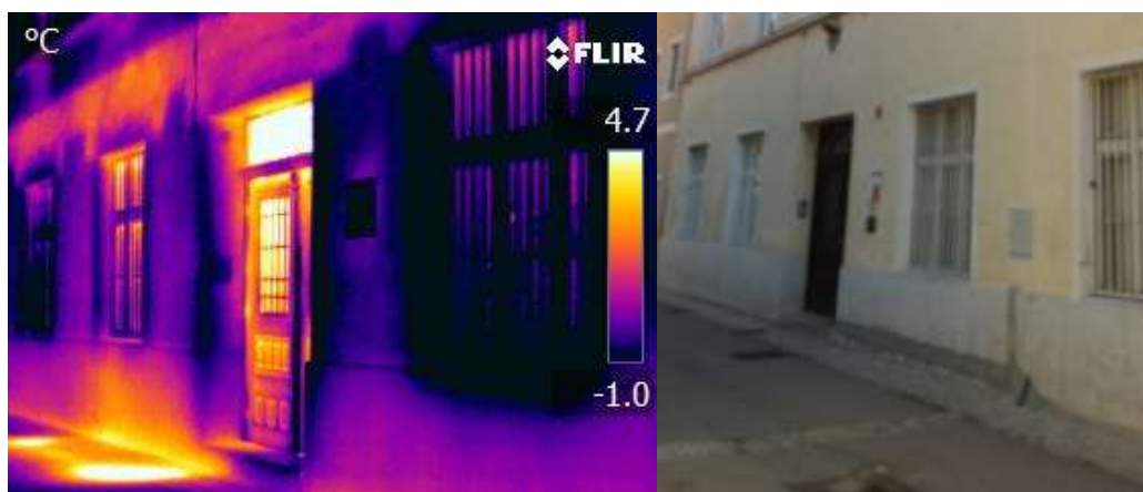
Slika 61: Termografski posnetek vhodnih vrat (levo), običajen posnetek fasade (desno)
