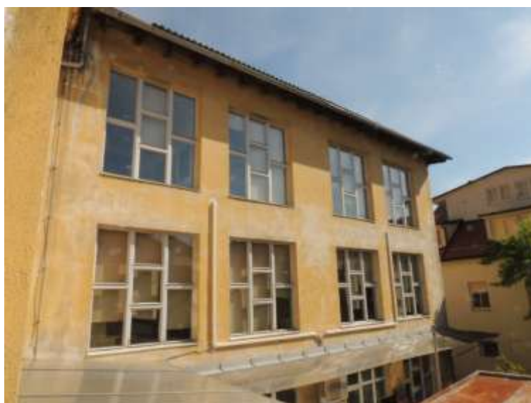
Slika 68: Južna fasada dvoriščnega prizidka z vezanimi okni večjih dimenzij
