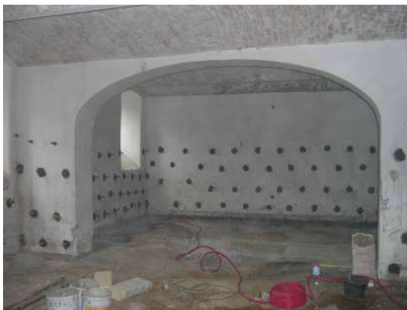
Slika 40: Sistematično injektiranje zidu (Vir: Popović, 2009)
