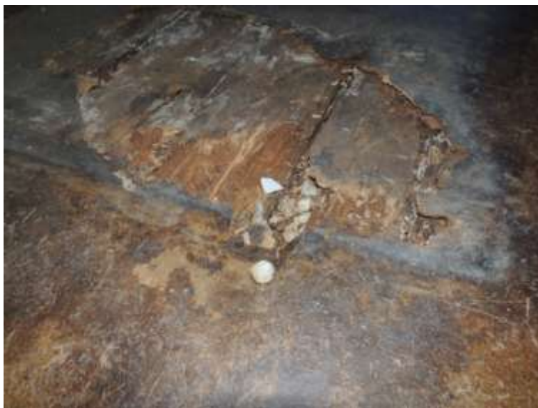
Slika 27: Sestava talne konstrukcije v mansardi
