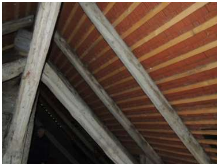
Slika 28: Ostrešje starejšega dela objekta
