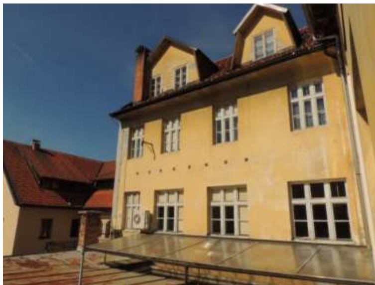
Slika 25: Pogled na dvoriščno fasado starega dela objekta
