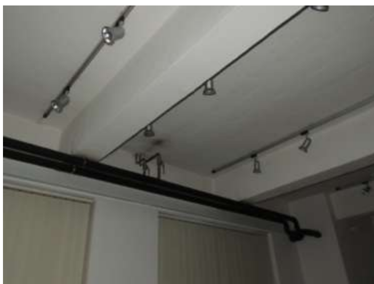
Slika 26: Betonski nosilci in nad nosilci betonska plošča - medetažna konstrukcija nad pritličjem
