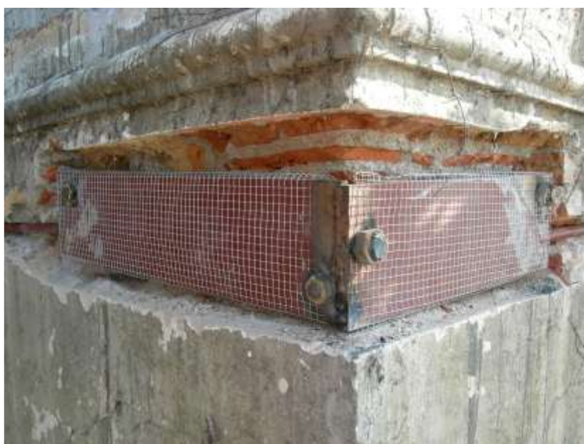
Slika 47: Primer vgradnje sidrne vogalne plošče z zavarjenimi maticami (Vir: Popović, 2009)
