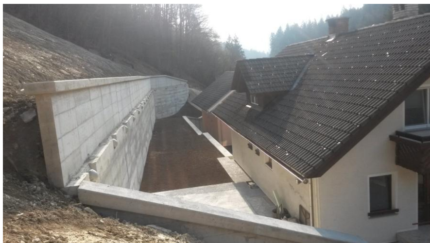
Slika 14: Stanje ob zaključku gradnje za hišo na parcelni številki 711/2 (lasten vir)
