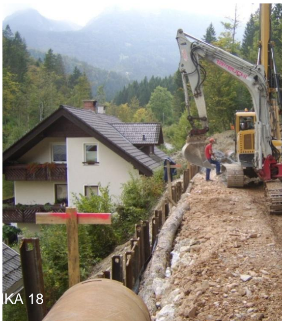
Slika 17: Izdelava platoja – zabijanje tirnic (lasten vir)
