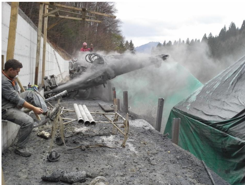
Slika 23: Vrtanje sidra z izpihovanjem, vidna zaščita strehe (lasten vir)
