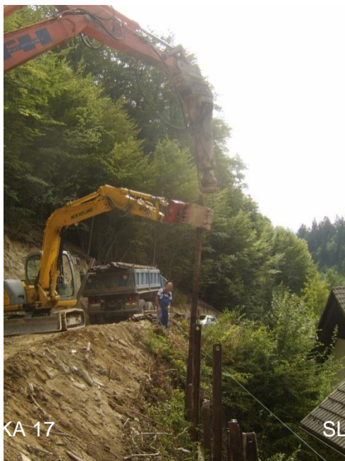
Slika 17: Izdelava platoja – zabijanje tirnic (lasten vir)
