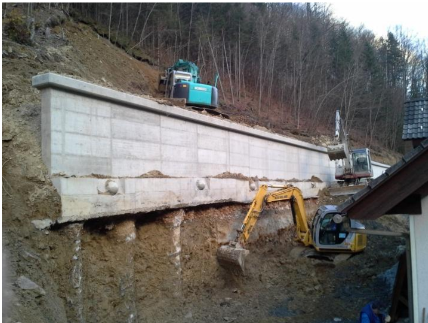
Slika 25: Izkop pod vezno gredo, premetavanje izkopnega materiala čez steno in planiranje brežine na vrhnjem delu plazu (lasten vir)
