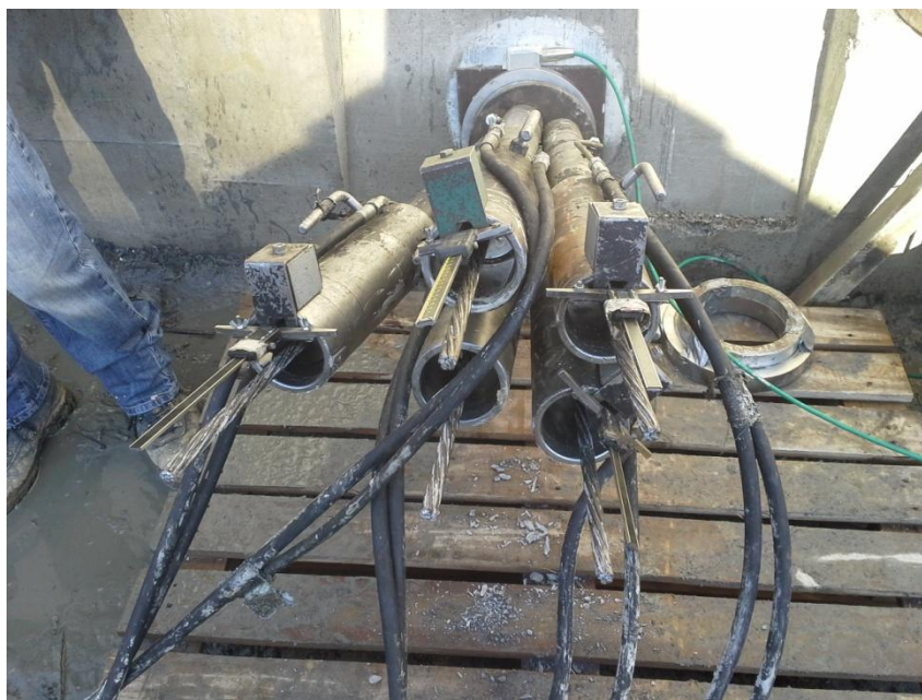
Slika 24: Napenjanje testnega sidra T1 (lasten vir)
