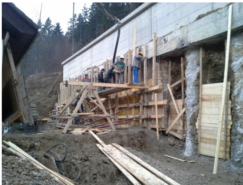
Slika 26: Betoniranje prve kampade stene pod armiranobetonsko gredo. Na desni strani slike so vidna drenažna rebra (lasten vir)
