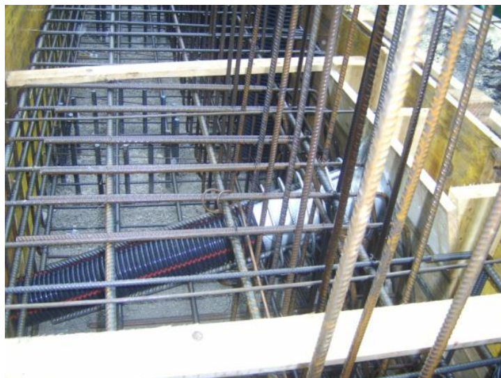
Slika 22: Sidrišče pod kotom 20–22° (lasten vir)
