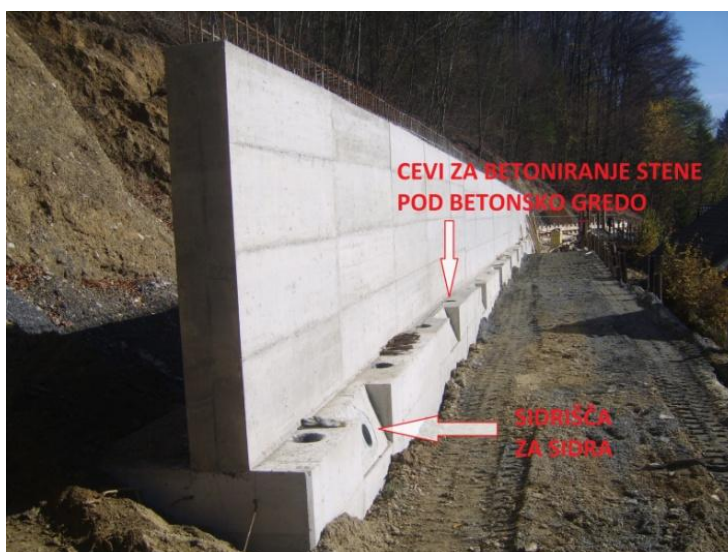
Slika 21: Betonska greda in stena nad gredo (lasten vir)
