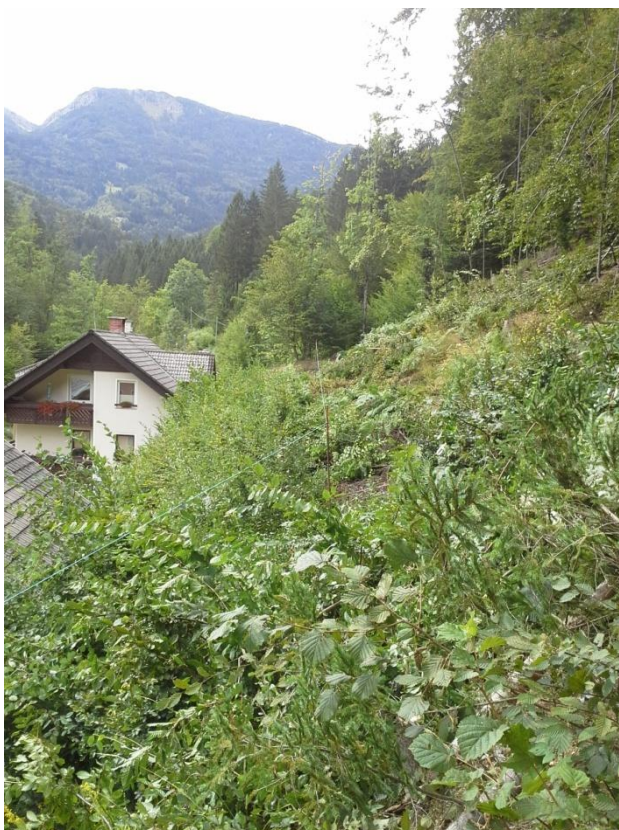
Slika 16: Zakoličba osi pilotne stene in začetek odstranitve dreves ter grmičevja (lasten vir)
