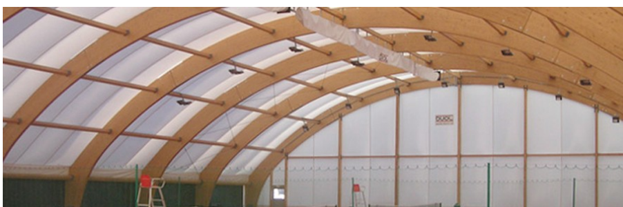
Slika 14: Primer lesene ločne dvorane prekrive z membrano (Inspired structures, 2015)
