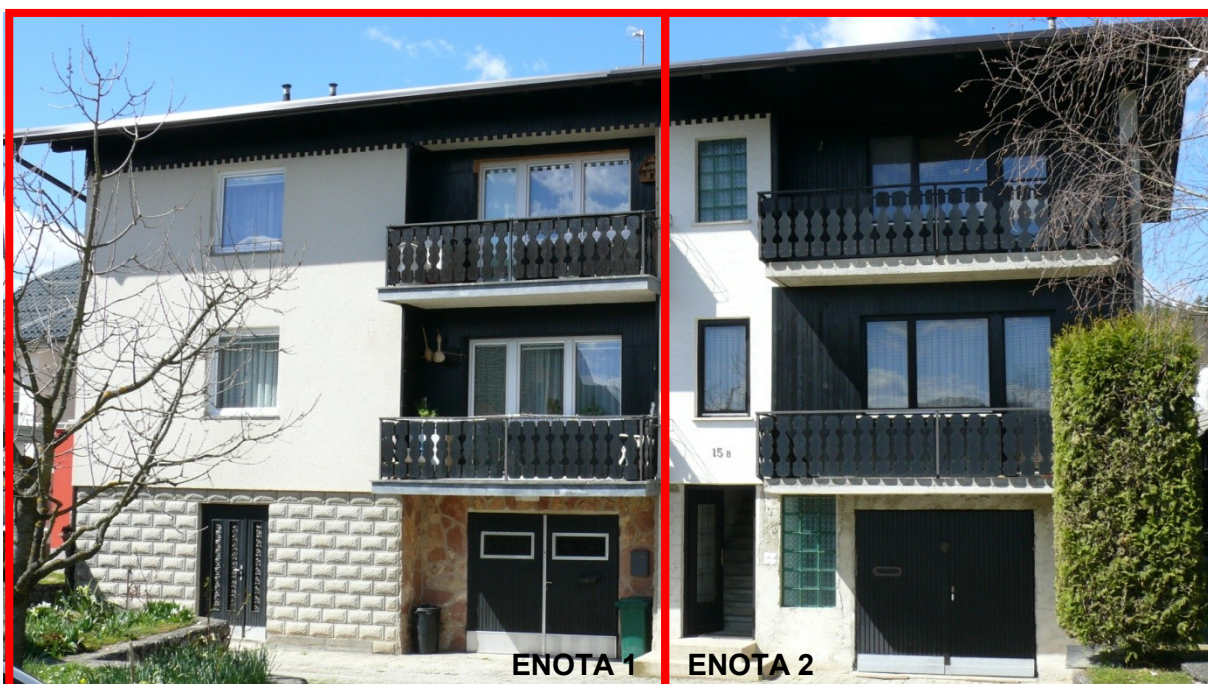
Slika 4: Manjša večstanovanjska stavba deljena na enoto 1 (E1) in enoto 2 (E2).
