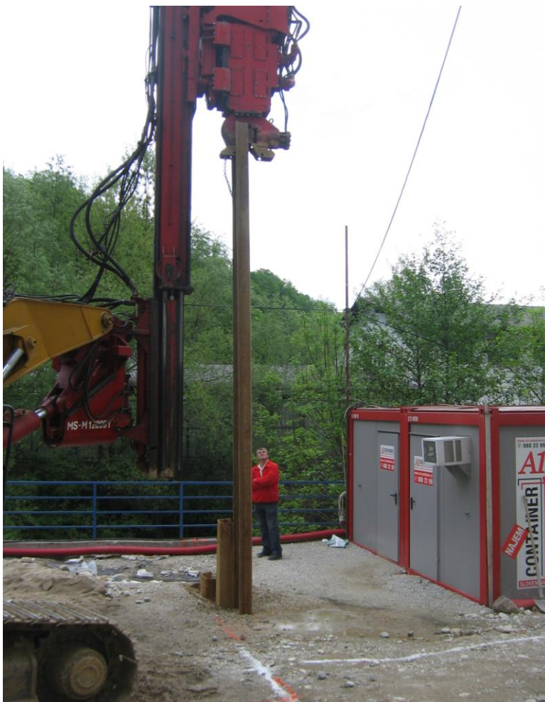
Slika 27: Vgradnja jeklenih zagatnic
