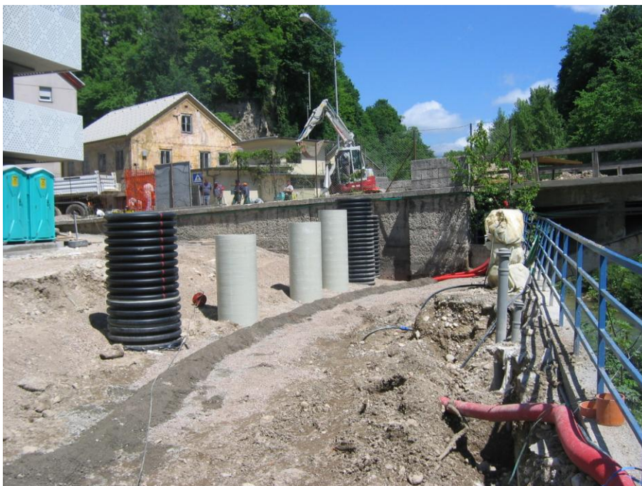
Slika 30: Elementi kanalizacije so vgrajeni
