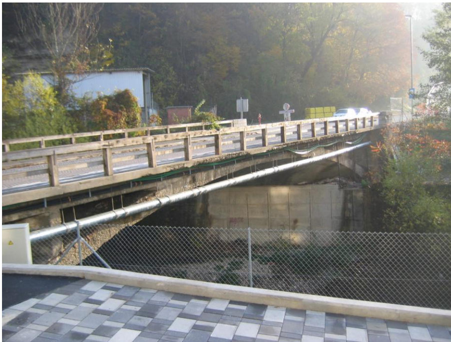
Slika 32: Pogled na most z desnega brega
