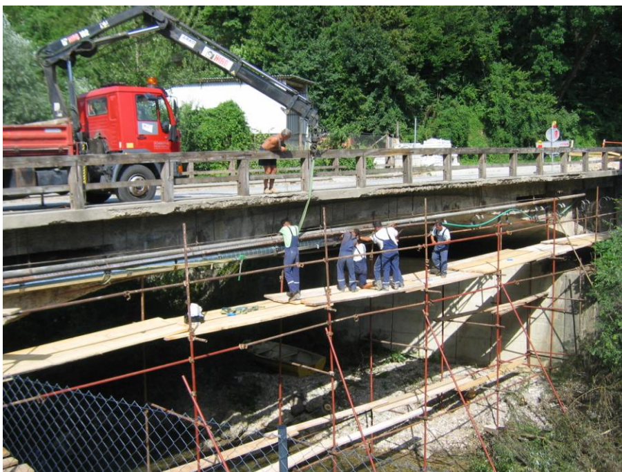
Slika 31: Obešanje predizolirane cevi na mostno konstrukcijo
