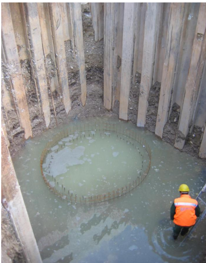
Slika 29: Nivo vode v gradbeni jami pred pričetkom del
