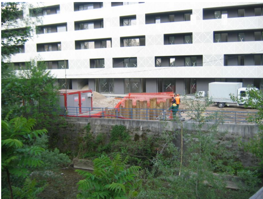
Slika 28: Gradbena jama varovana z jeklenimi zagatnicami
