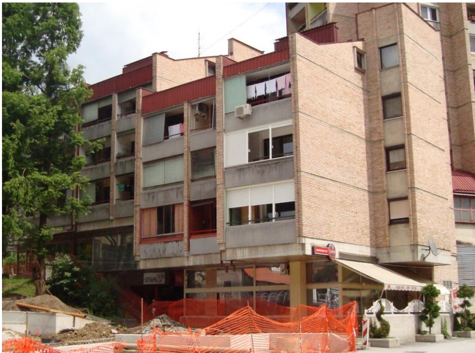
Slika 1: Stanovanjski blok na Cesti 9. avgusta 8abc, pogled na južno in zahodno fasado (vir: lasten)
