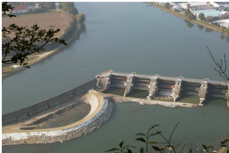
Slika 2. Izgradnja male hidroelektrarne Melje ( http://maribor24.si/ )
