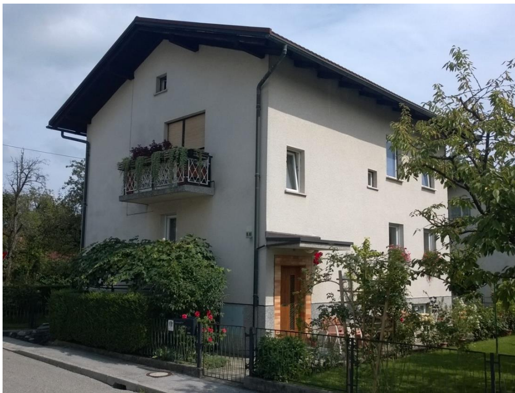
Slika 2: Slika severozahodne in jugozahodne fasade (lasten vir, 2015)
