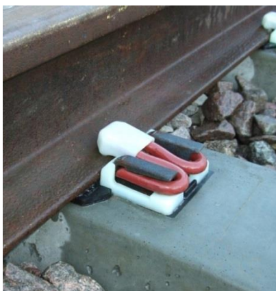
Slika 11: Sistem elastične pritrditve imenovan Pandrol ( http://www.railway-news.com/pandrol-track-systems-and-fastening-materials , pridobljeno: 23.8.2015)
