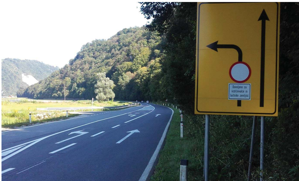
Slika 12: Rekonstrukcija glavne ceste pri priključku D-4
