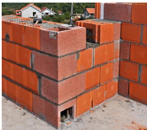
Slika 14: Vertikalne armiranobetonske vezi (Internetni vir, pridobljeno 5.8.2015)
