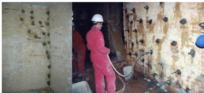
Slika 11: Injektiranje (Internetni vir, pridobljeno 3.8.2015)
