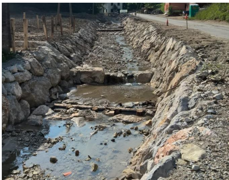
Slika 11: Hotoveljščica, zaporedje pragov iz grobo zloženega kamenja v suho in nižje ležeči prag iz lesenih oblic podprt z zloženim kamenjem v suho (avtor, terenski ogled, 1.6.2015).
