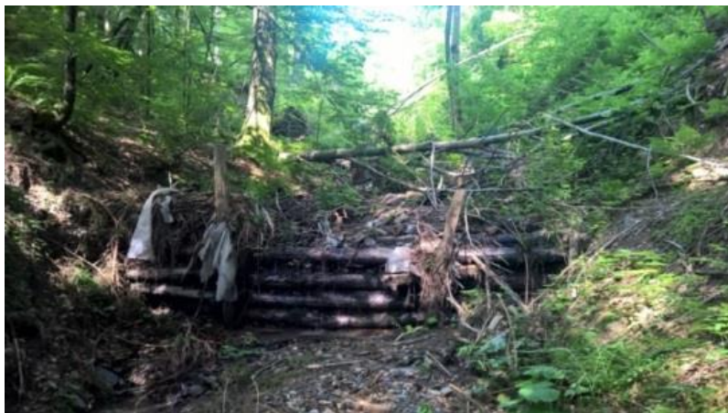
Slika 43: Zadrževalnik hudourniških plavin na hudourniku Hotoveljščica (avtor, terenski ogled, 1.6.2015).
