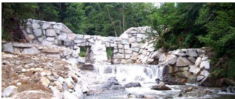
Slika 24: Masivna prebiralna pregrada na Radoljni (Društvo vodarjev Slovenije, 2004).
