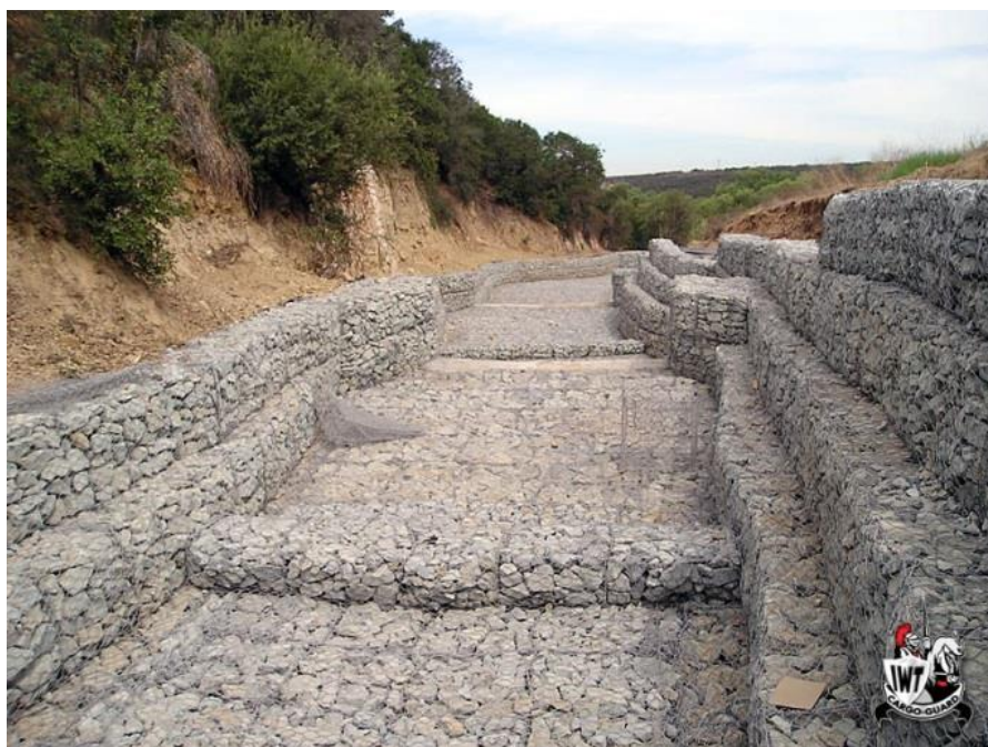
Slika 36: Žične košare za ureditev struge (IWTC/Cargo-Guard, 2012).
