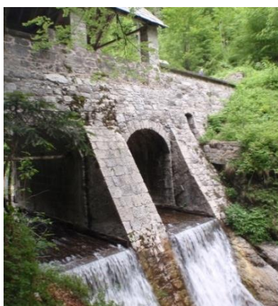
Slika 31: Izpustni del Brusovih ali Belčnih klavž z odprtinama za odvajanje vode in plavljenega lesa (Kladnik, 2010).
