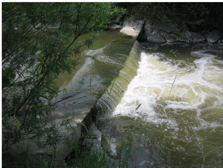
Slika 10: Prag s podaljšanim prelivom (ANTIENSEN, 2013).
