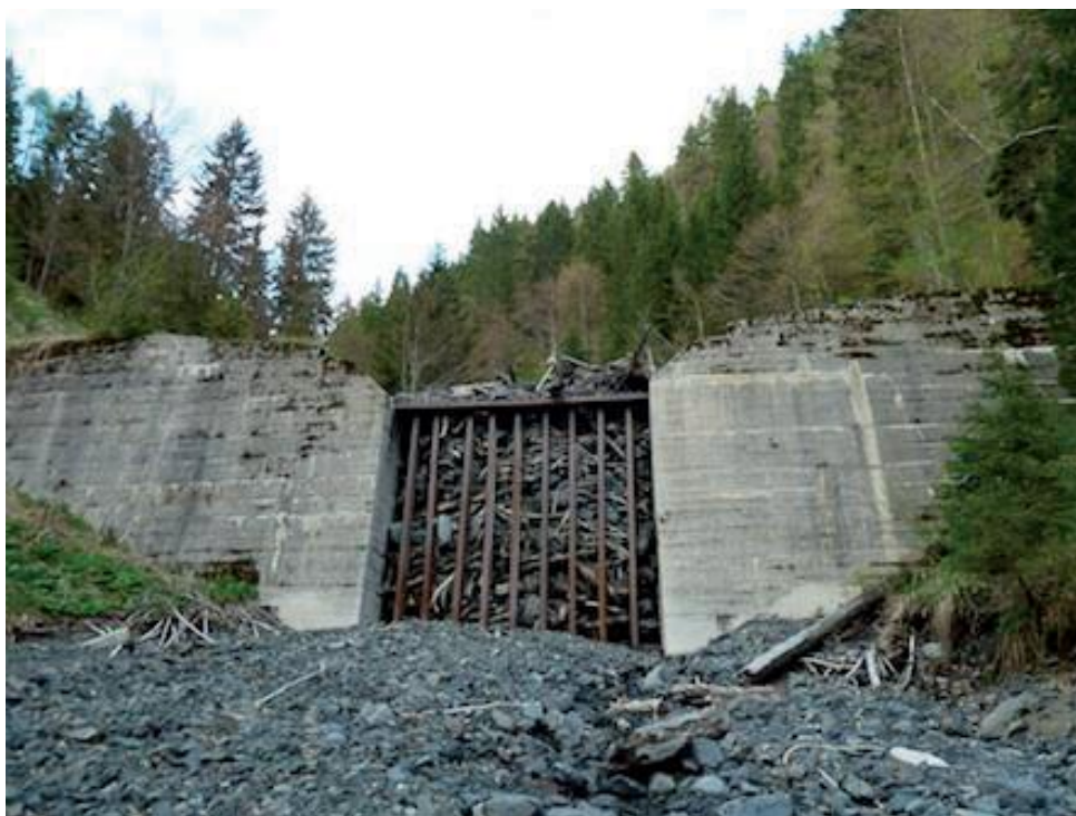
Slika 18: Primer zapolnjene filtrirno zadrževalne pregrade na hudorniku Suhelj (SedAlp WP6, 2015).
