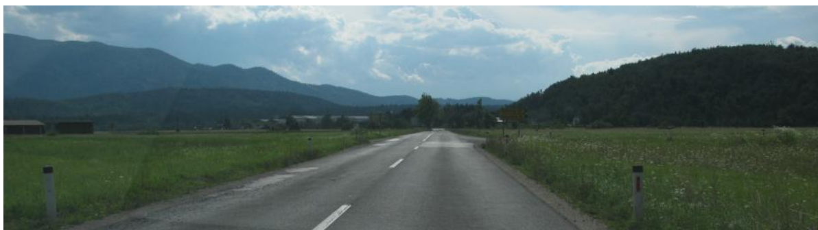
Slika 4: Pogled na križišče 1 s kraka B
