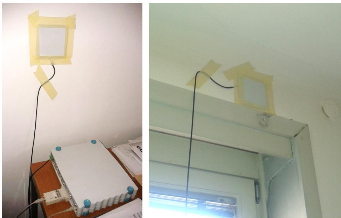
Slika 15: Merilnik toplotnega toka pritrjen na steno v 1. nadstropju in pretvornik (levo) in na preklado v 2. nadstropju (desno)
