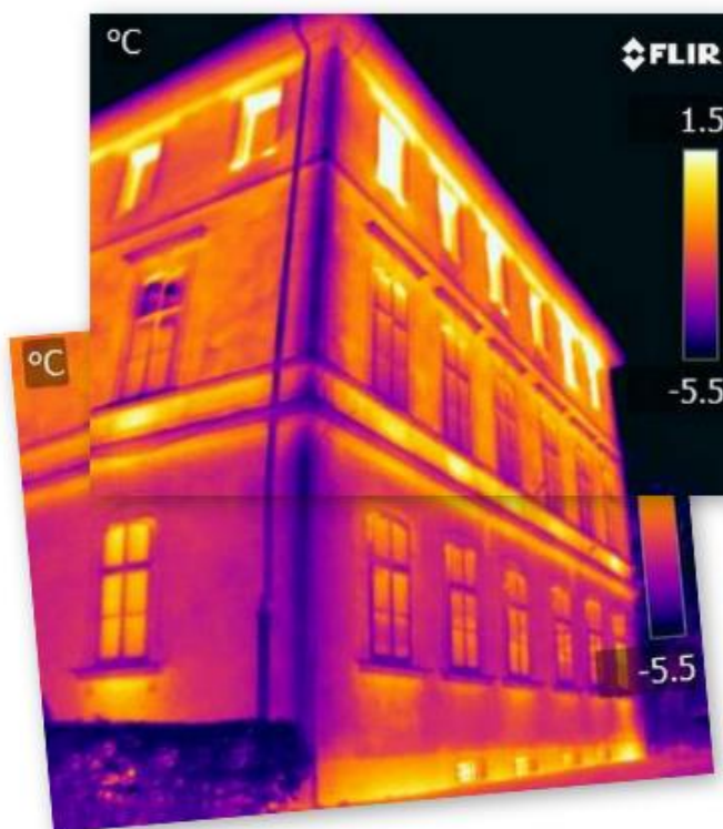
Slika 11: Termografski posnetek južne fasade
