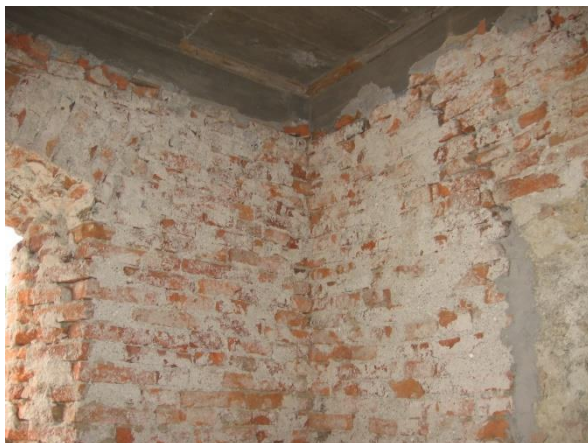
Slika 5: Nosilni zidovi 1. nadstropja; opečni zid – neregularna zidna zveza v vogalu (Štampfl, 2008)
