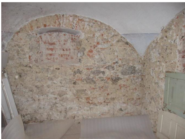
Slika 3: Nosilni zidovi pritličja; mešani kamnito-opečni zid – vidne pozidave odprtih odprtih (Štampfl, 2008)
