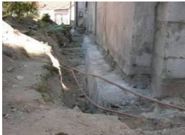
Slika 13: Primer ojačitve temeljev (Keše, 2015)
