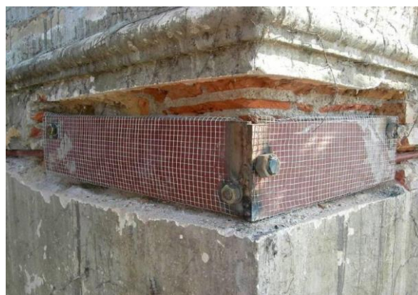
Slika 11: Sidranje na jekleno podložno ploščo (Keše, 2015)
