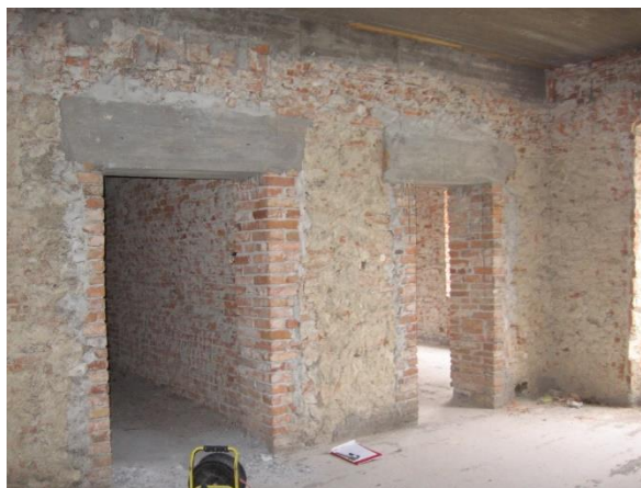
Slika 4: Nosilni zidovi prvega nadstropja; mešani kamnito-opečni zid; vidne pozidave ob odprtinah in izvedba AB-preklad (Štampfl, 2008)
