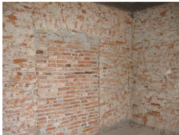
Slika 6: Nosilni zidovi prvega nadstropja; opečni zid – vidna pozidava odprtine (Štampfl, 2008)
