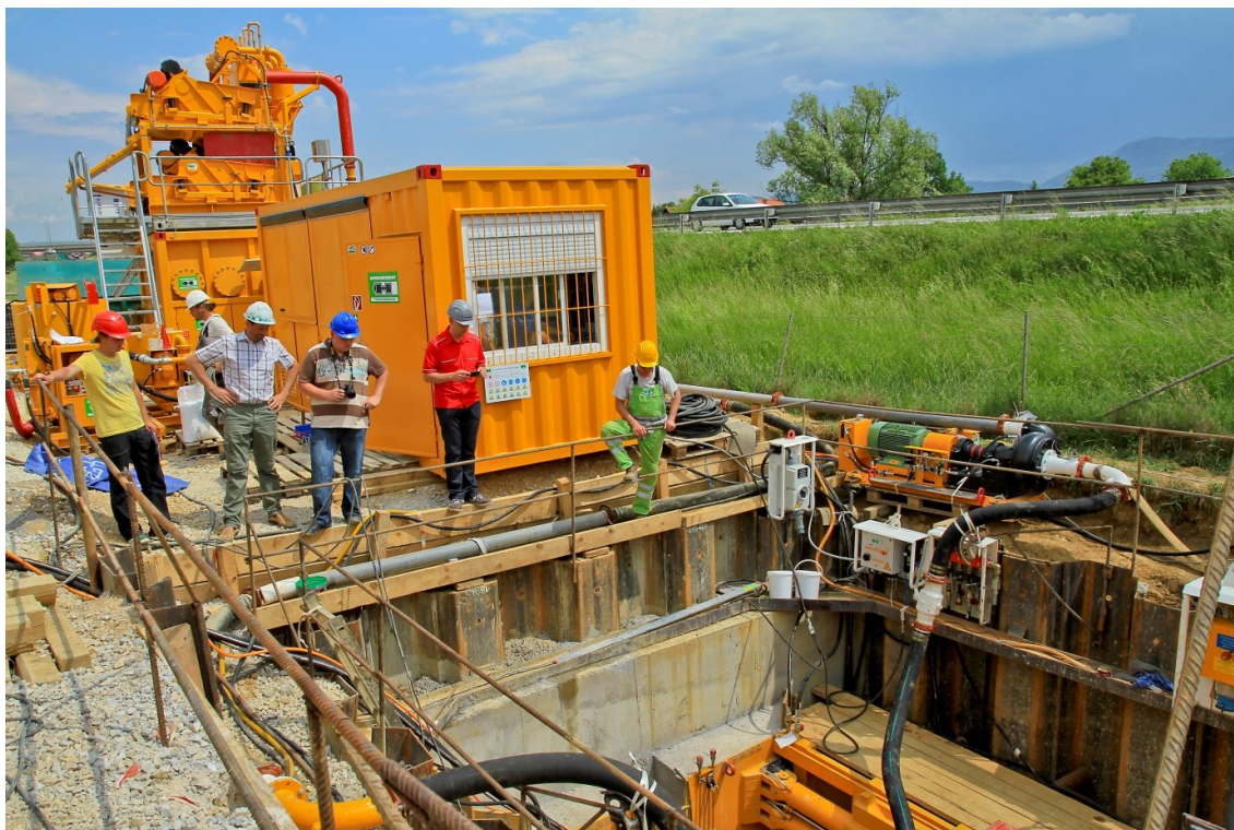
Slika 2: Kontrolna kabina ob vstopni gradbeni jami
