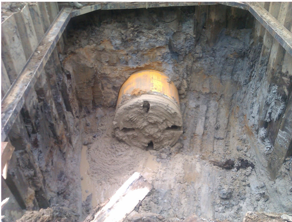
Slika 41: Preboj vrtalnega stroja v izstopno gradbeno jamo – mikropredor Zgornja Hudinja
