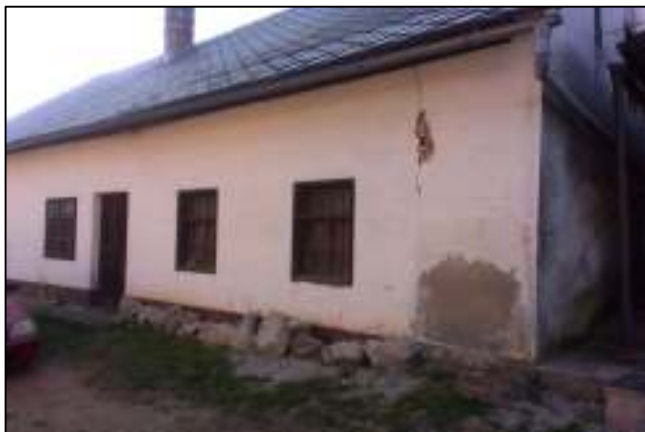
Slika 13: Zapuščena kmečka hiša, zgrajena leta 1719 (Vir: Lasten arhiv, december 2014)
