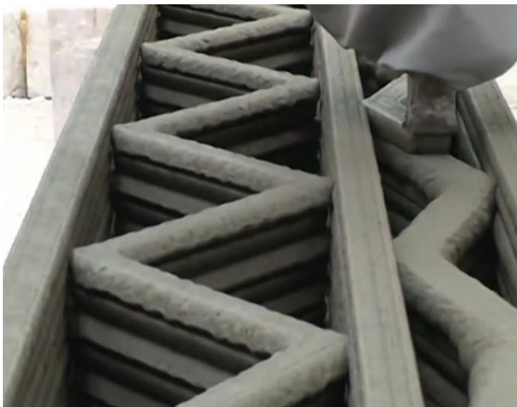
Slika 3: Uporaba 3D tiskalnika v Gradbeništvu
