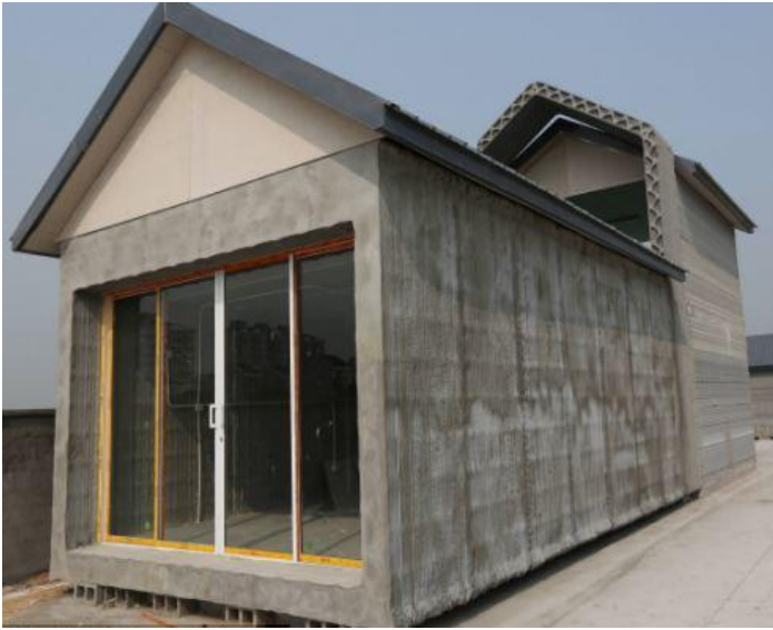
Slika 4: Prva hiša natisnjena s 3D tiskalnikom
