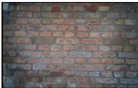
Slika 6.8: Zid iz polne opeke v apneni malti (Ortonali, 2012).
