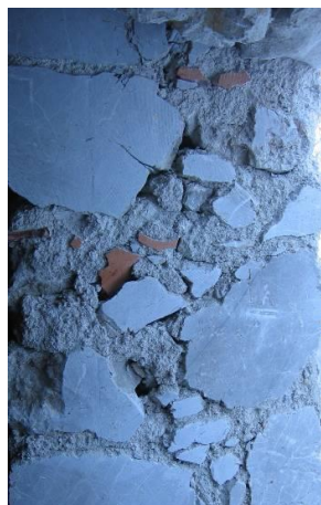
Slika 6.6: Kamniti zid podeželske hiše v vasi Čezsoča (Uranjek, 2011).
