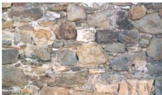
Slika 6.7: Zid iz neobdelanega kamna z omejeno debelino in polnim jedrom (Ortonali, 2012).
