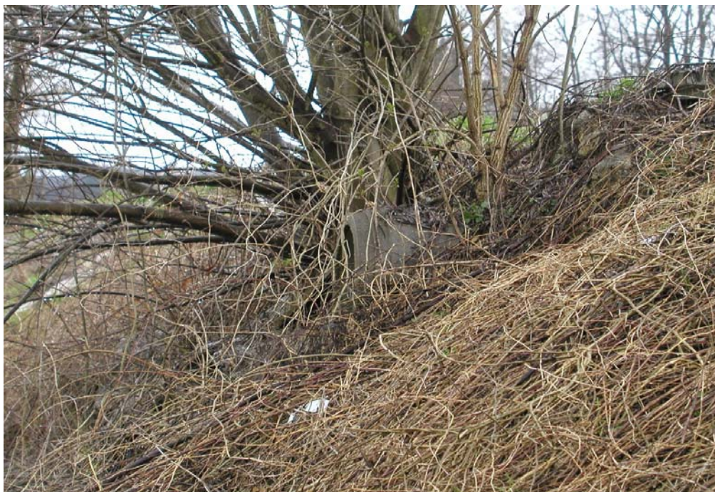
Slika 10: Betonska cev na brežini Zbiljskega jezera
