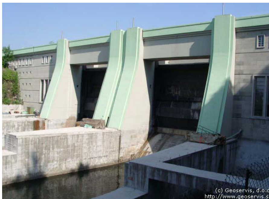
Slika 7: Hidroelektrarna Medvode (vir: http://www.geoservis.si/instrumenti/hds/cyra-hidroelektrarna.htm (7.4.2006))
