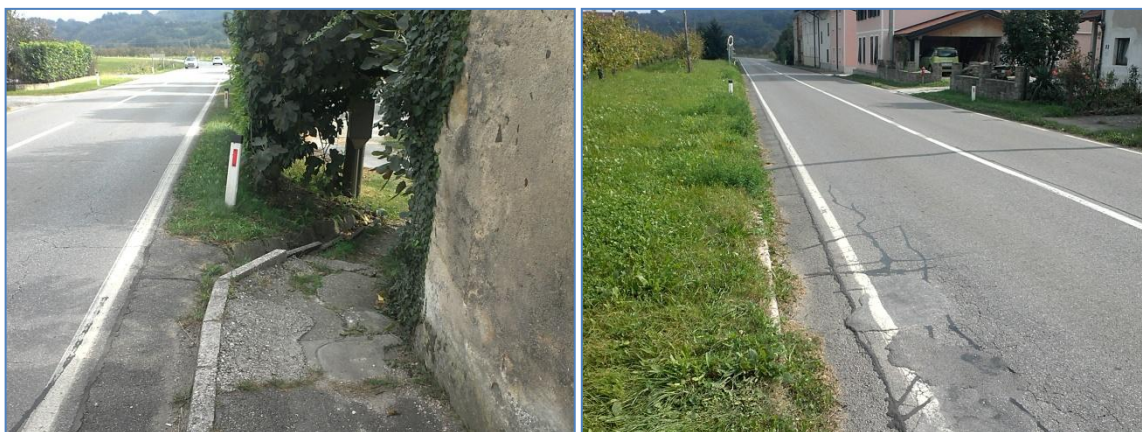
Slika 8: neurejeno odvodnjavanje cestišča preko koritnic
