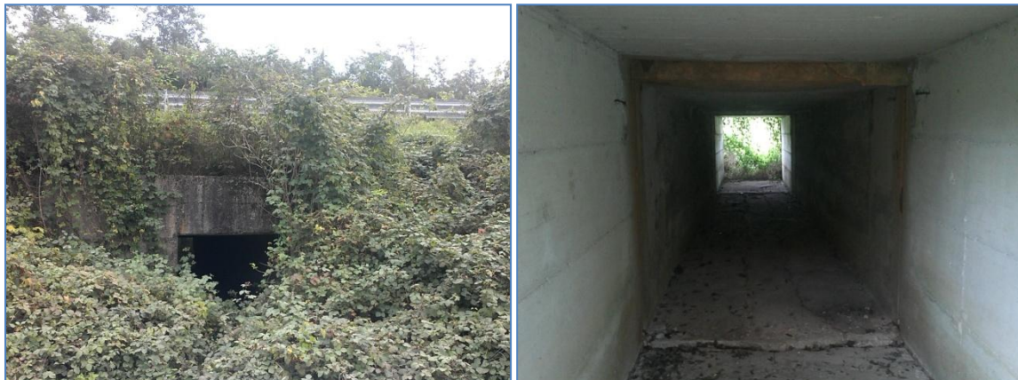
Slika 32: poplavni prepust lociran pod cestiščem v nasipu
