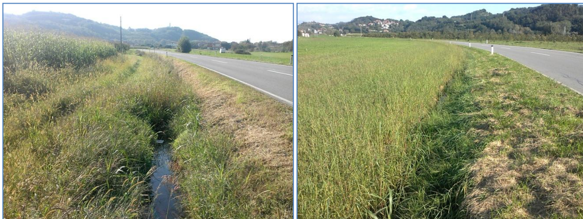
Slika 7: zaraščen (levo) in neustrezno urejen (desno) obcestni jarek
