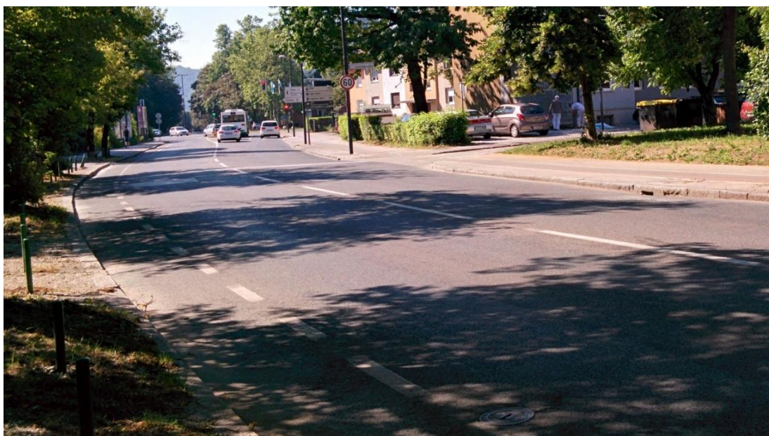
Slika 8: Trenutno stanje: Topniška ulica med Linhartovo in Vojkovo ulico, Ljubljana
